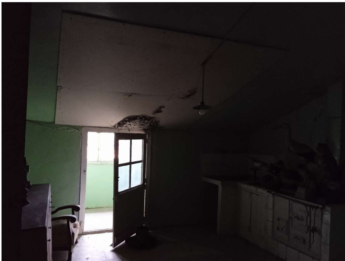
Uno de los graneros de la última planta, donde se aprecian las humedades de la cubierta.
