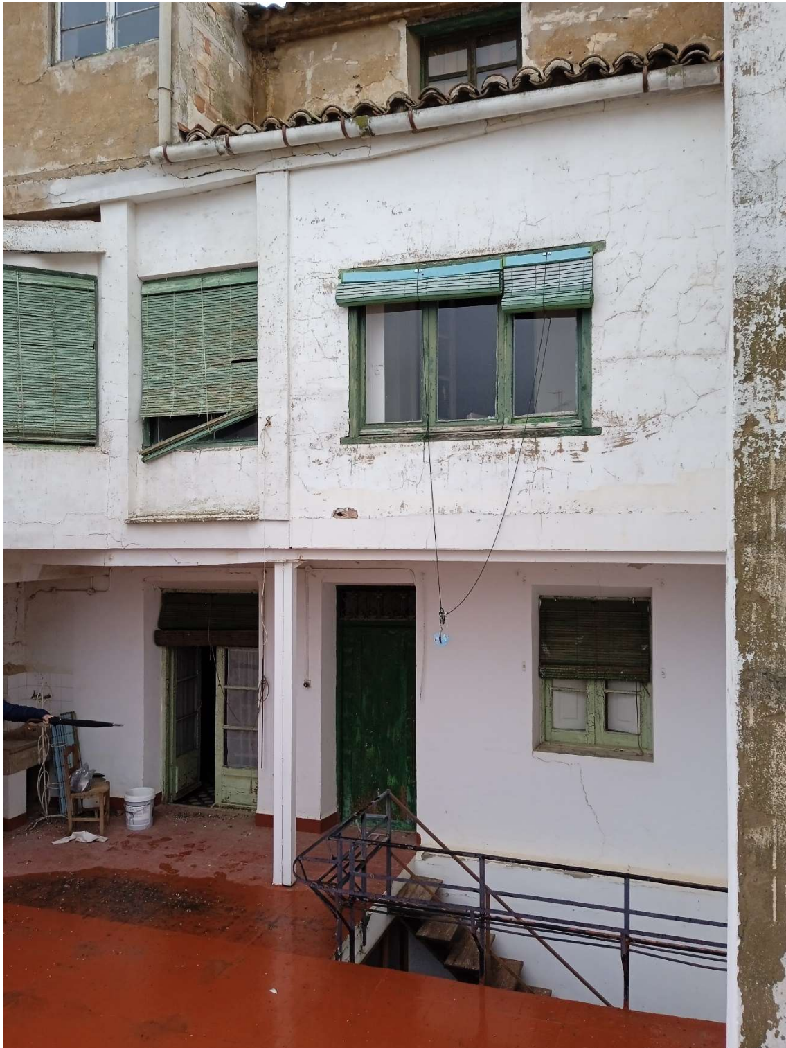
Fotografía de la fachada del patio interior
