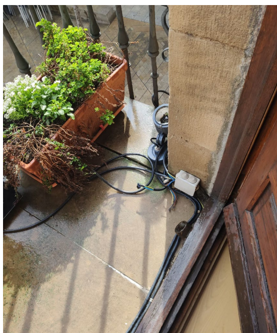
DETALLE DE LUMINARIAS EN FACHADA PRINCIPAL
