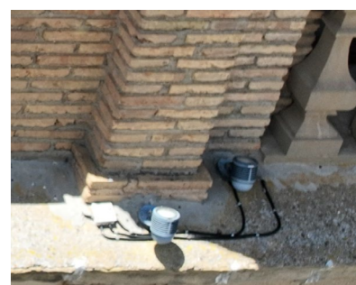
LUMINARIAS EN CORONACIÓN DE FACHADA PRINCIPAL
