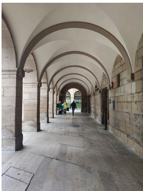
VISTA GENERAL INTERIOR DEL PÓRTICO
