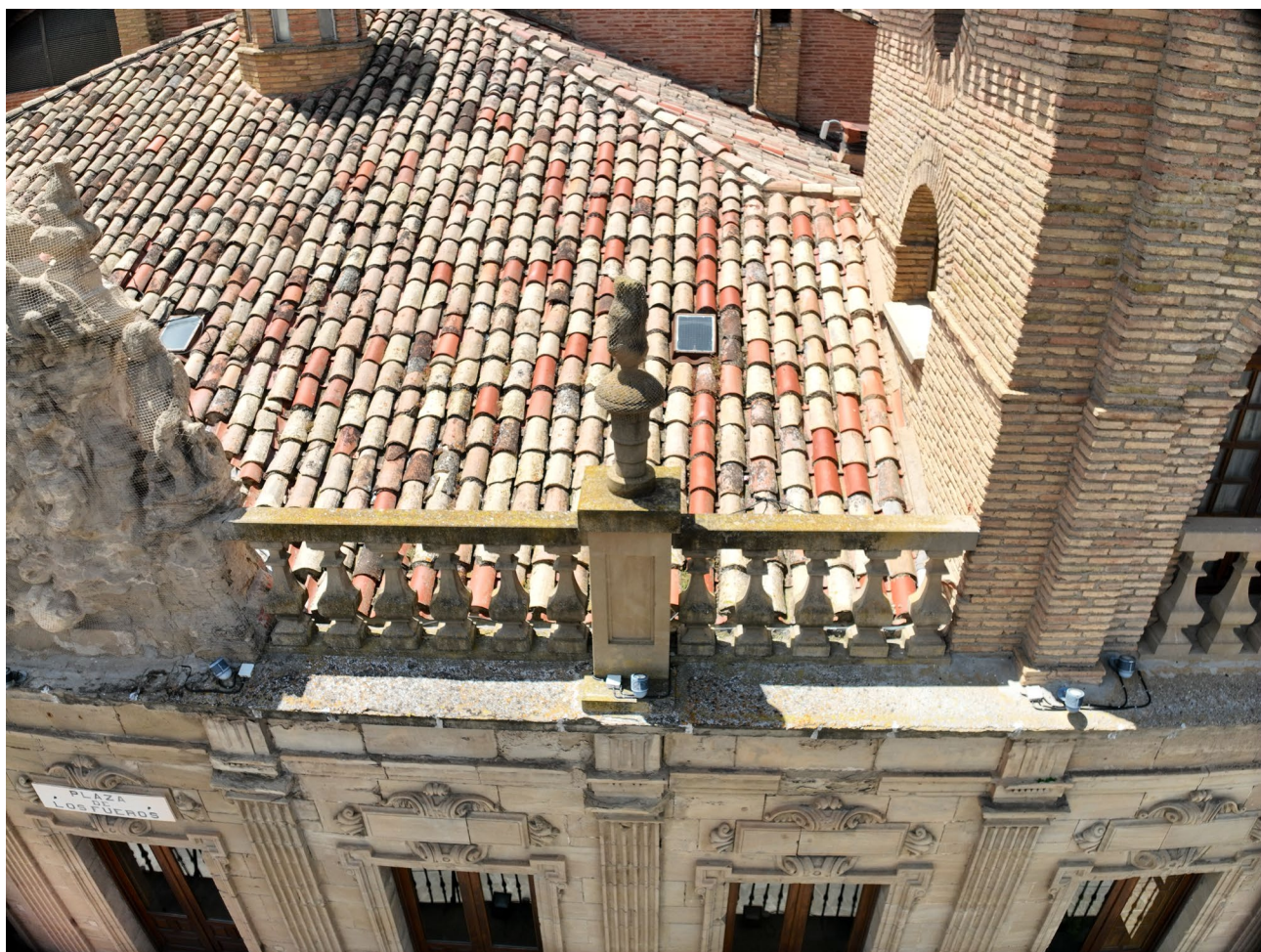
LUMINARIAS EN CORONACIÓN DE FACHADA PRINCIPAL
