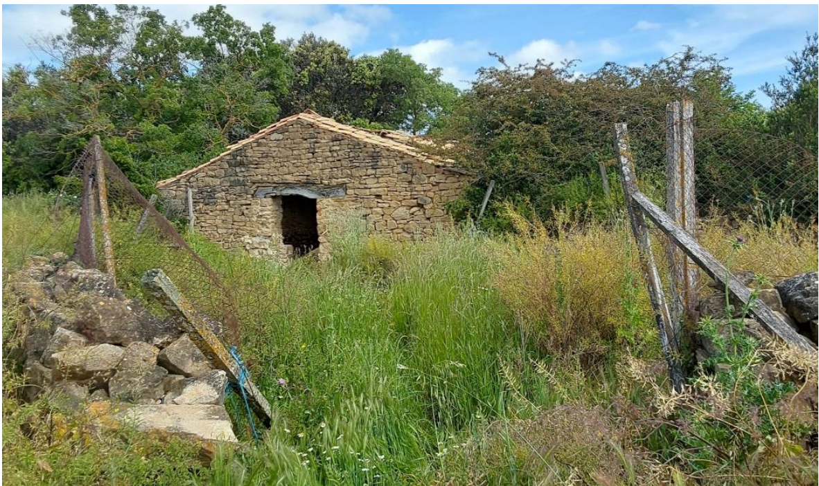
Fachada sur y acceso al recinto
