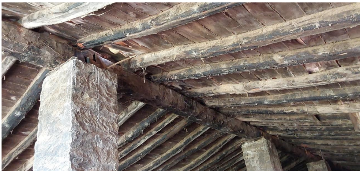
Solivos de cubierta
