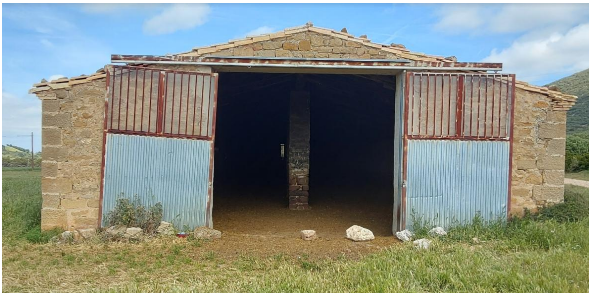
Fachada sureste y puerta
