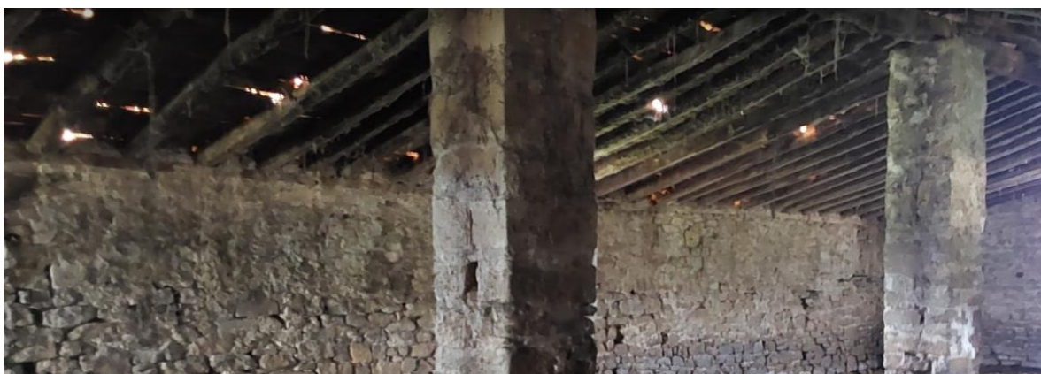
Entrada de luz por huecos en cubierta
