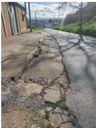
Zona central, cuneta este.
