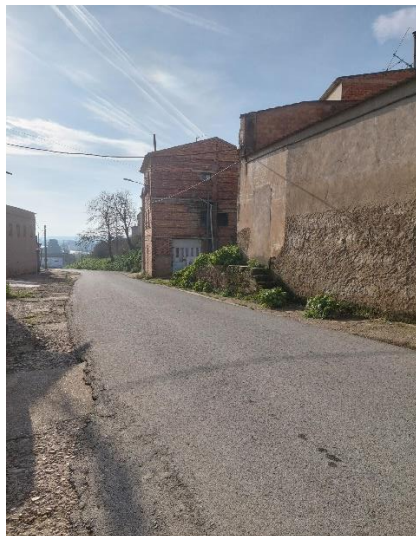
Escalera invadiendo la cuneta, a demoler.
