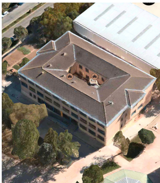
Acceso y vista Noroeste
