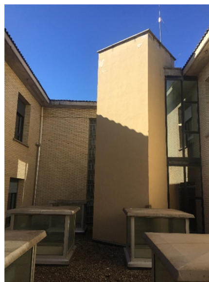
FACHADA PATIO Y ASCENSOR
