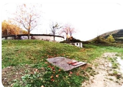
F5 Registro exterior paso ramal alta FN100
