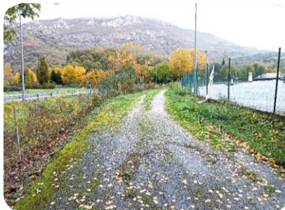
F25 Pk3+740 al Pk3+760 curva camino serv.
