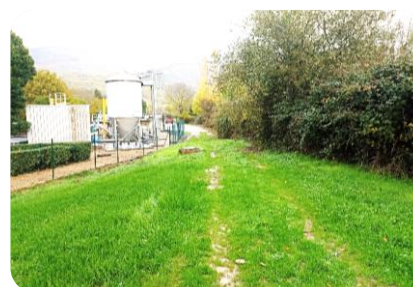
F12 Vista paso estrecho en PA Este EDAR
