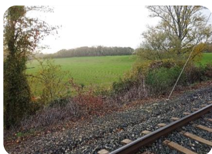
F23 Vista retroceso campo PK2+235-PK2+020
