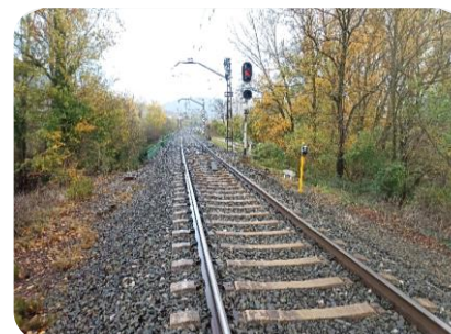
F25 PK2+335 cruce línea FFCC hincia rígida
