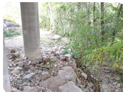
F33 Vista escollera protección pilares
