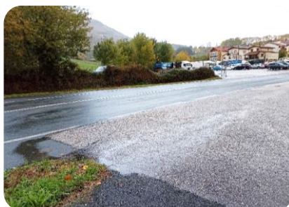
F27 Tramo cruce N-240-A Pk3+820
