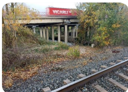
F26 PK2+335 a PK2+370 paso bajo A-15
