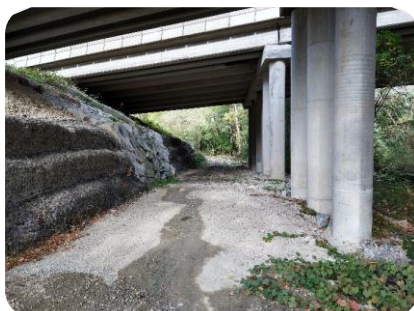
F32 Vista protección gaviones/escollera estribo
