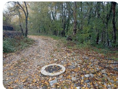
F31 PK2+410 final paso bajo A-15 por camino
