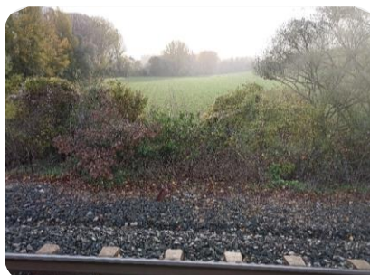
F24 Vista retroceso PK2+300-2+250
