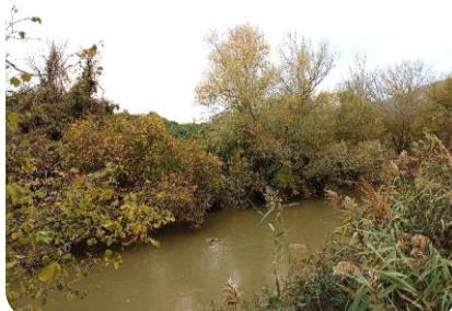
F17 Cruce perforación dirigida Arakil Pk1+500
