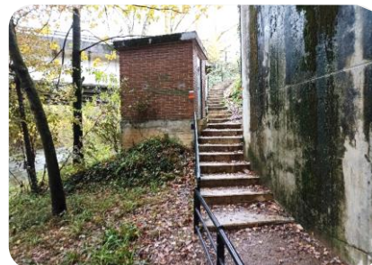
F3 Pk0+050 salida bajo estribo A-15
