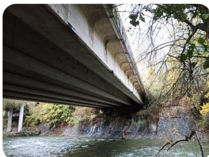
F8 Vista tablero vigas ramal A-15/NA-2410
