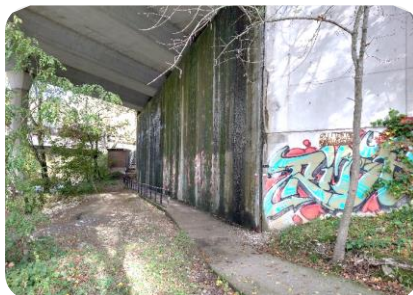
F2 Pk0+020-Pk0+050 estribo A-15
