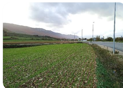
F9 Vista retroceso Pk1+030 vaina DN600
