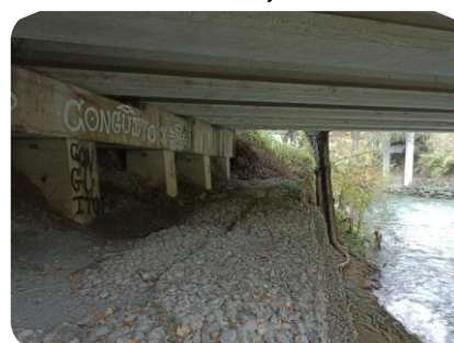
F6 Vista retroceso Pk0+080-Pk0+060 estribo
