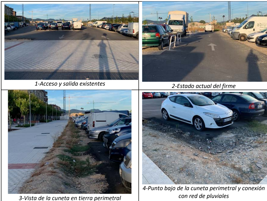
Figura nº 4: fotografías del estado actual del aparcamiento de Chantrea Sur
