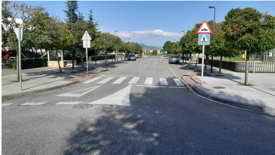
Zona a reformar en calle La Morea
