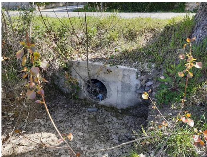
Fotografía 3.- Salida de la obra de drenaje a ampliar
