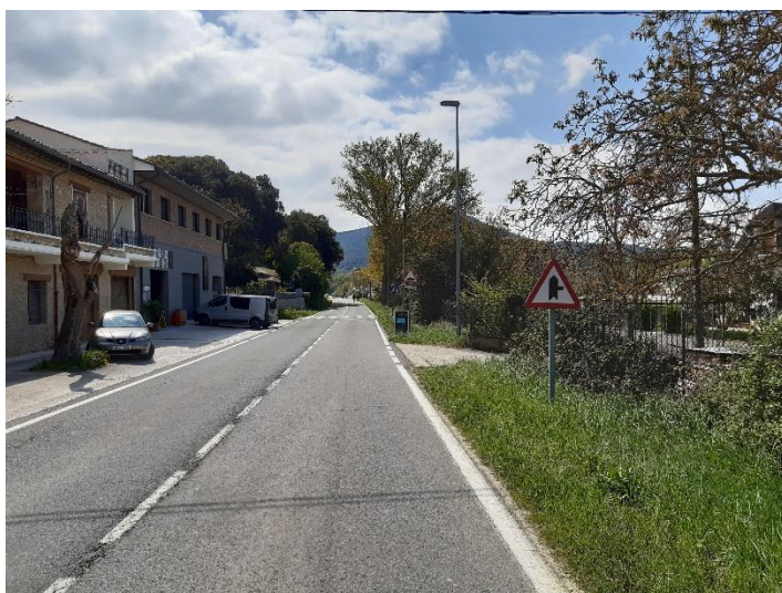
Fotografía 2.-Estado actual del margen izquierdo junto a la calzada NA-718, donde se proyecta la acera y el carril bici
