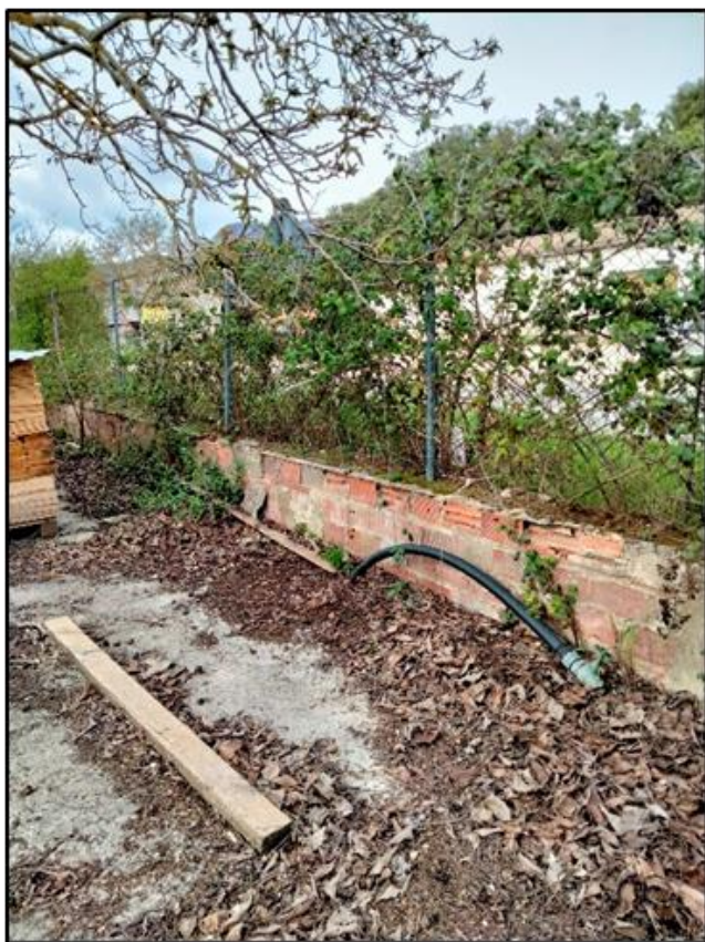
Fotografía 4. - Vista del muro de ladrillo y valla a retranquear.
