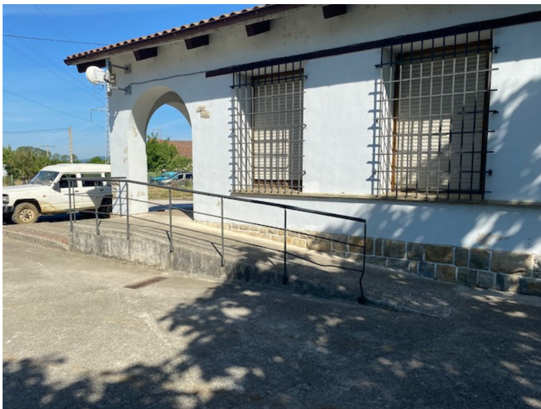
Detalles de la entrada (accesibilidad), con escalones y rampa
