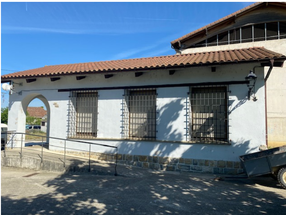
Fachada principal del edificio, con el elemento saliente en planta semisótano, bajo terraza de acceso
