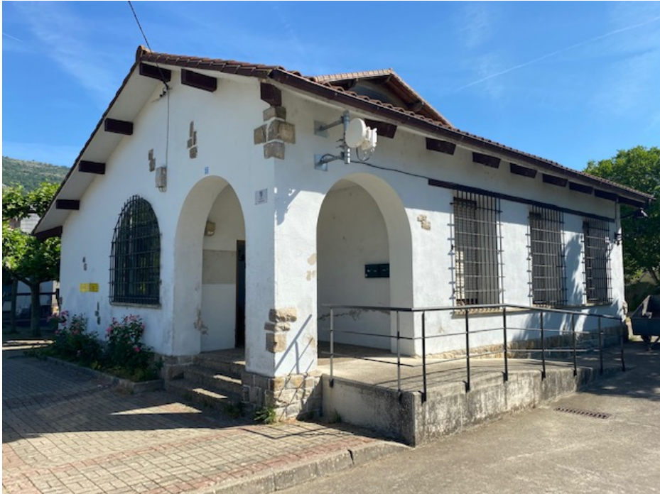
Fachadas principales del edificio, por donde se realiza el acceso, desde zaguán exterior.
