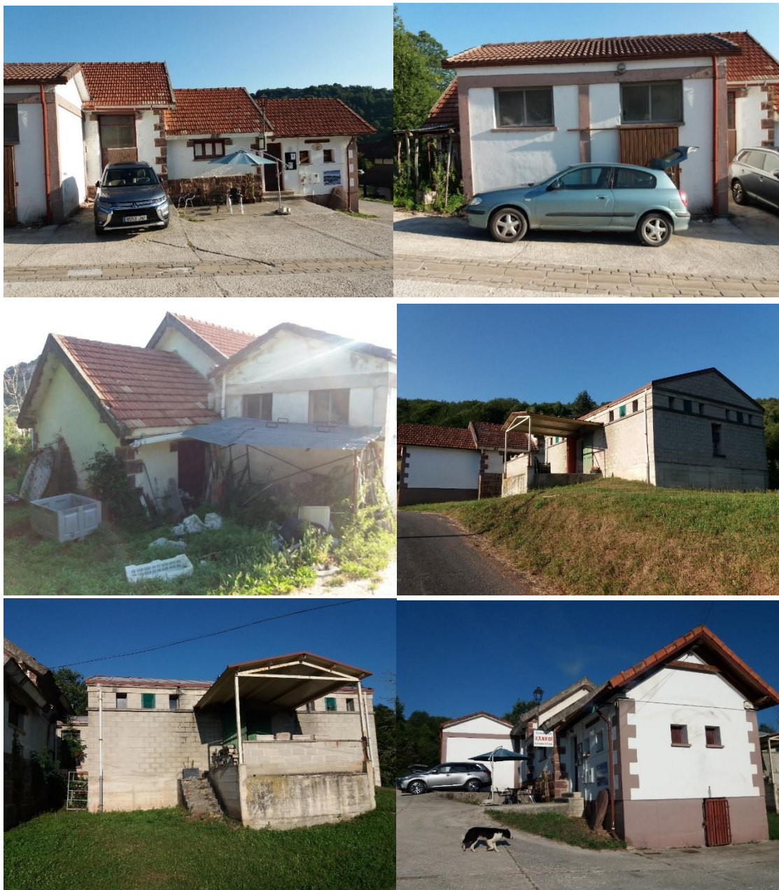
Imagen 7 Vista exterior de las edificaciones que conforman el Matadero de Garralda
