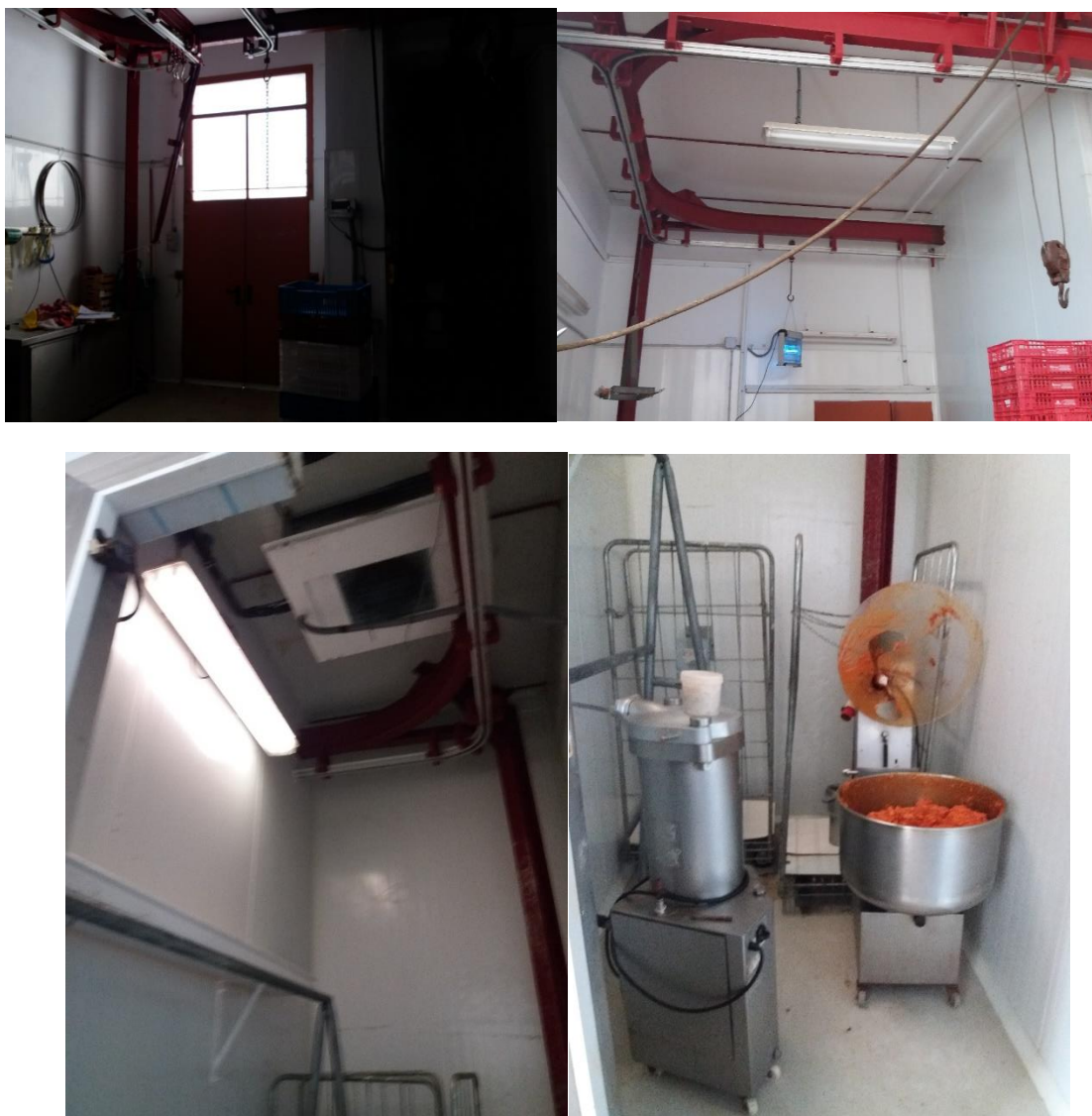
Imagen 8 Vista interior de las edificaciones que conforman el Matadero de Garralda
