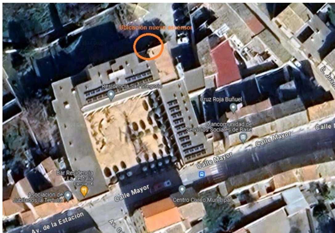
Vista aérea del edificio
