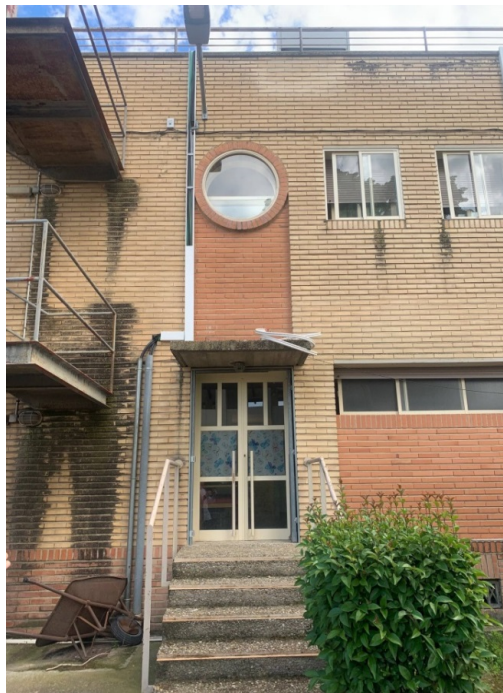
Ubicación del nuevo ascensor en fachada trasera.
