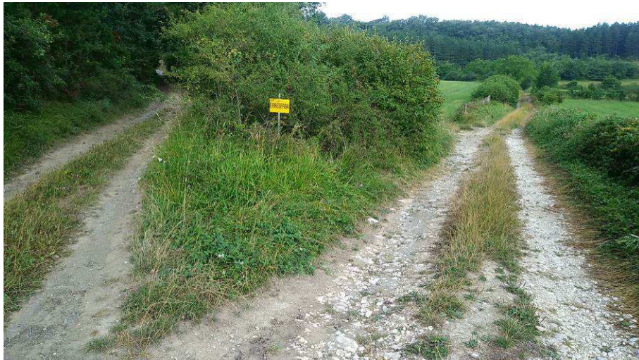
Ilustración 2. Estado actual del camino Irura
