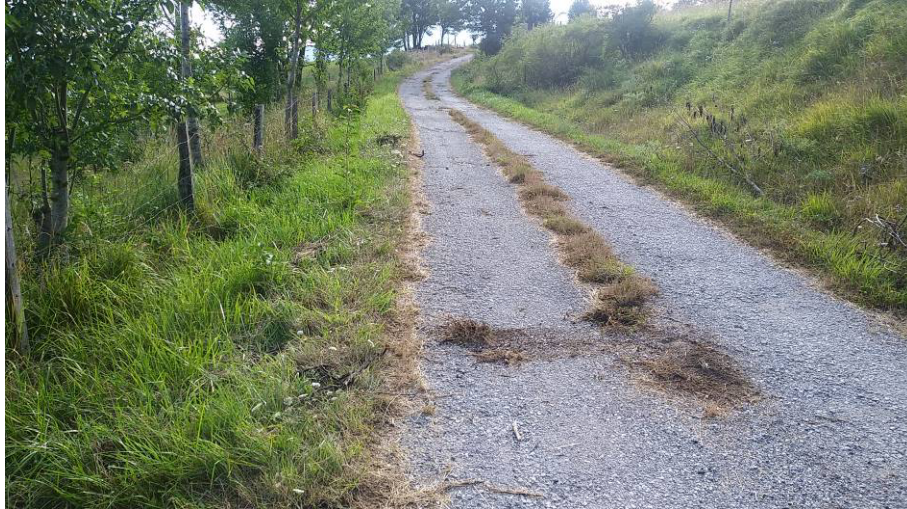
Ilustración 1. Estado actual del camino Irura
