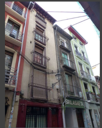
PA-5 Jarauta 31-33 El 33 tramitada licencia de obras
