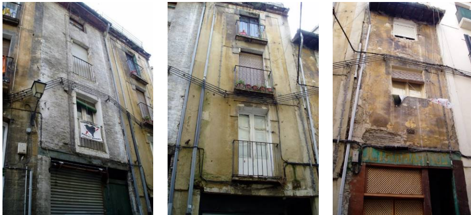
Edificaciones preexistentes de Descalzos 23, 25 y 27
