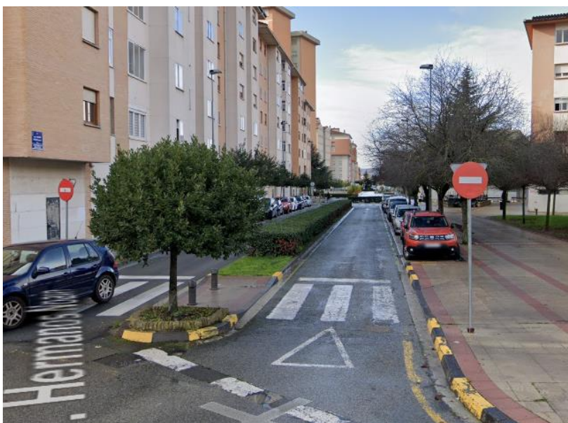
Estado actual de la calle Hermanos Noáin
