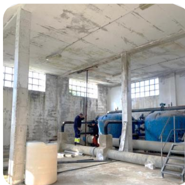
F20: Problemática apuntalamiento viga 1/3 Oeste por pérdida recubrimiento.
