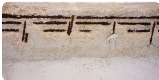
F21: Problemática apuntalamiento viga 1/3 Oeste por pérdida recubrimiento del hormigón armado.
