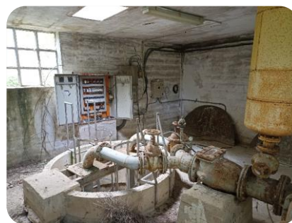
Foto 2: Interior caseta antiguo bombeo
