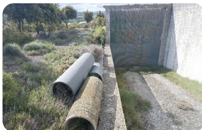
F5: Rampa acceso cámara de llaves.
