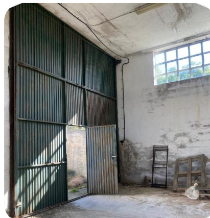
F26 Acceso a cámara llaves adyacente a muro Oeste Vaso
