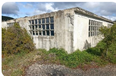
Foto 4: Vista Sureste cámara llaves
