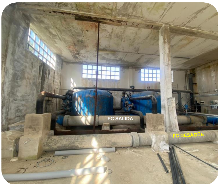
F21: Problemática apuntalamiento viga 1/3 Oeste por pérdida recubrimiento del hormigón armado.
