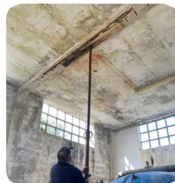
F20: Problemática apuntalamiento viga 1/3 Oeste por pérdida recubrimiento.
