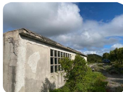
F10: Vista Sureste cámara llaves
