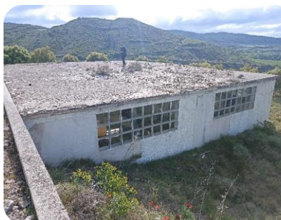
Foto 2: Vista Noroeste cámara llaves
