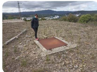
F3: Vista general cubierta y acceso vaso
