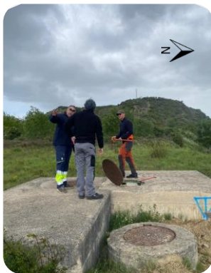
F2.1: Nudo derivación Dep PI junto antiguo nudo bombeo
