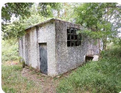
Foto 1: Caseta antiguo bombeo a. bruta
