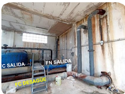
F11: Entrada/Salida conducciones vaso
