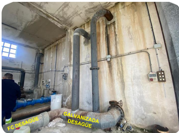
Foto 25: Vista pared frontal (Sur) vaso en c. llaves sin ventanas/pasarela inspección
