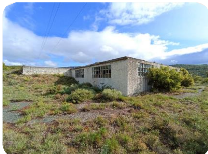
F1: Vista Suroeste cámara llaves y vaso
