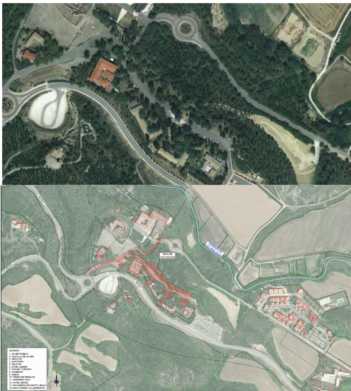
Edificios de actuación: nº 7, 8, 9 y 10 (9 tan solo tejado)
