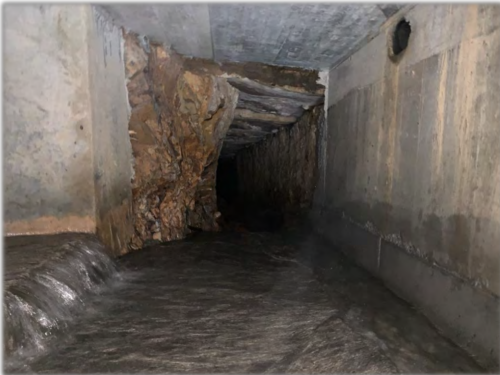
Fotografía 2: Inicio del canal a arreglar.
