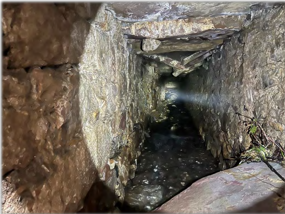
Fotografía 4: Interior del canal a arreglar.
