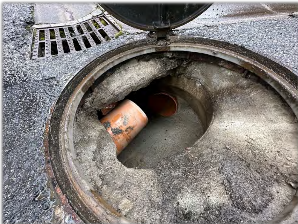
Fotografía 8: Colector de pluviales que vierte al canal en Gernikako Arbola Zeharbidea.
