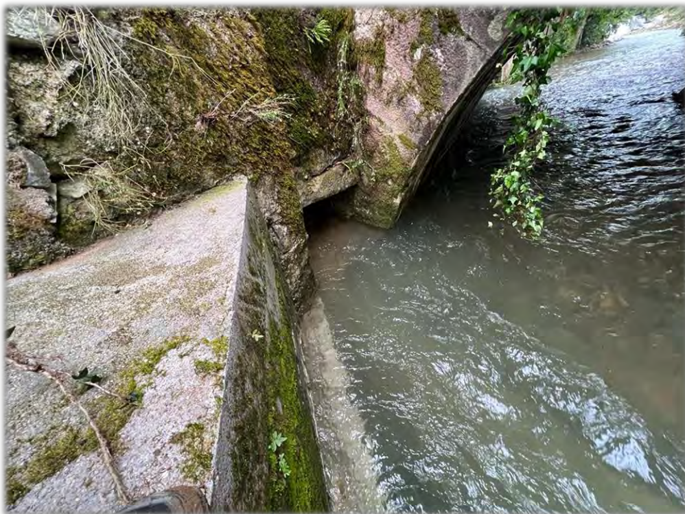
Fotografía 12: Salida al río Zia del canal a arreglar.
