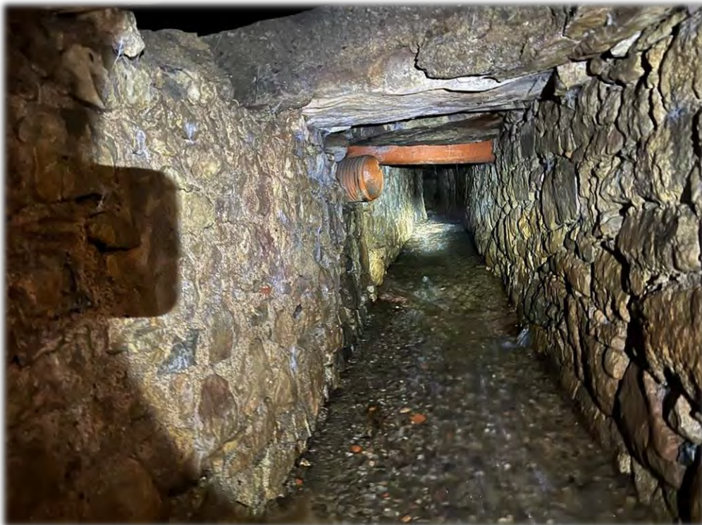
Fotografía 3: Interior del canal a arreglar.
