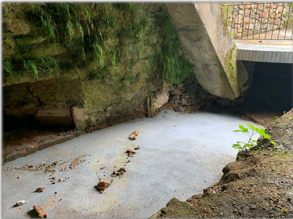
Fotografía 1: Embocadura de entrada del canal a arreglar.
