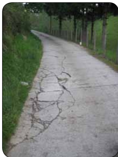
Paños de hormigón deteriorados
