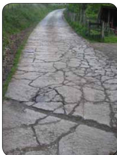
Paños de hormigón deteriorados
