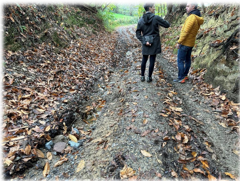
Fotografía 7: Roderas creadas por la escorrentía superficial y pérdida del material de rodadura.
