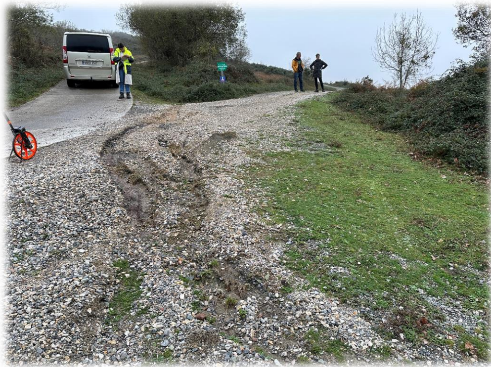
Fotografía 8: Punto en el que se construirá nueva cuneta de hormigón.
