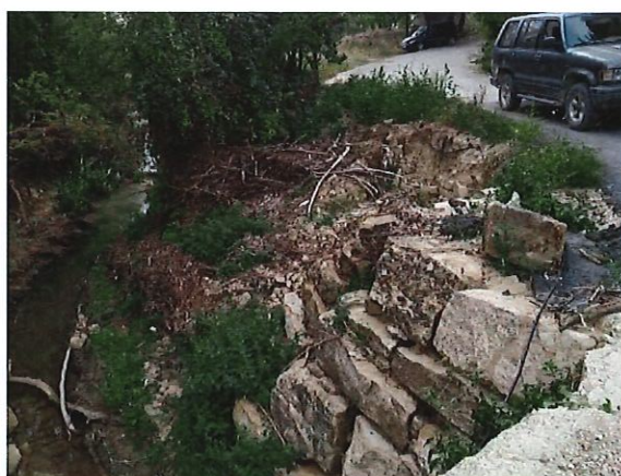
CAMINO 26 – Escollera de protección afectada. Desprendimientos.
