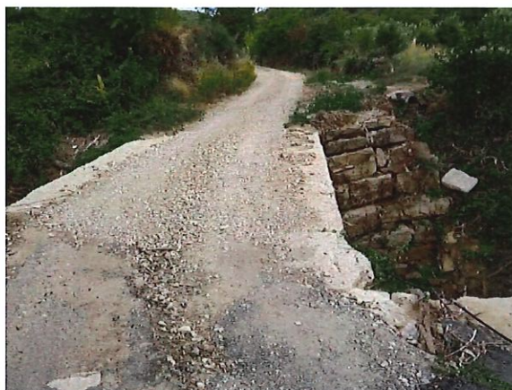
CAMINO 26 – Paso con estribos afectados por la fuerza del agua.
