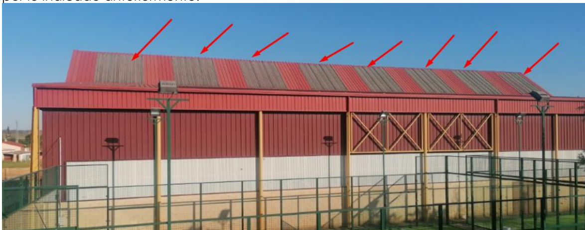
Vista exterior actual de los lucernarios a sustituir
