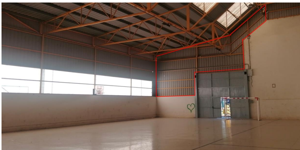
Vista interior de la fachada afectada
