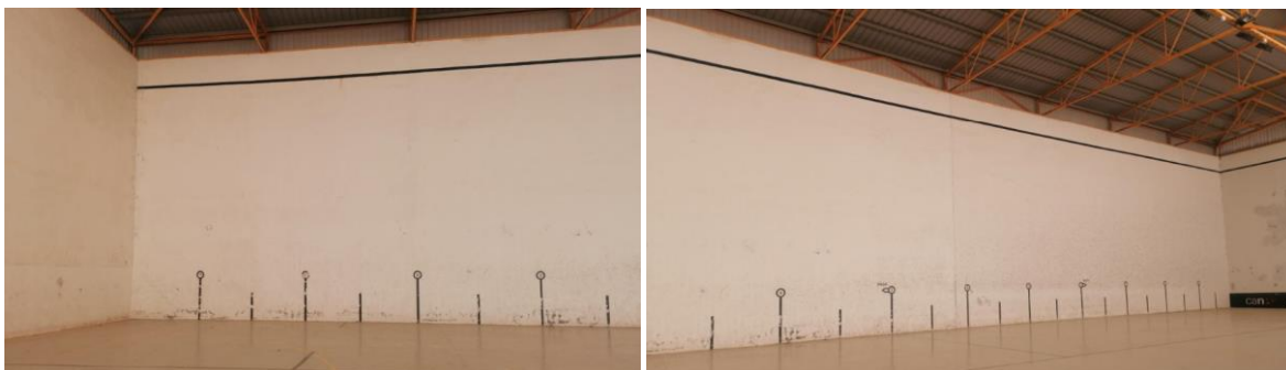
Estado actual de la pared lateral
