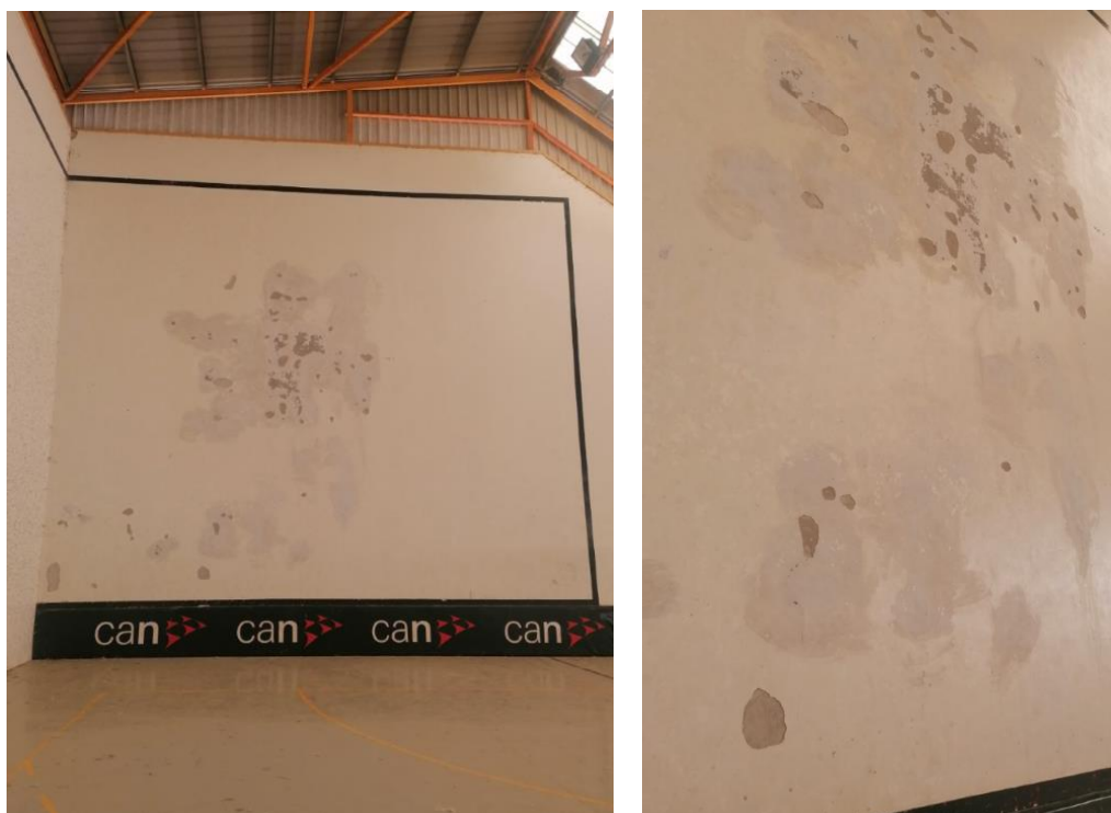
Estado actual del frontis
