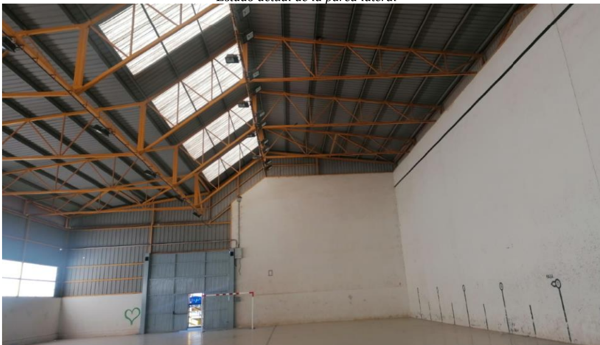
Estado actual de la pared trasera
