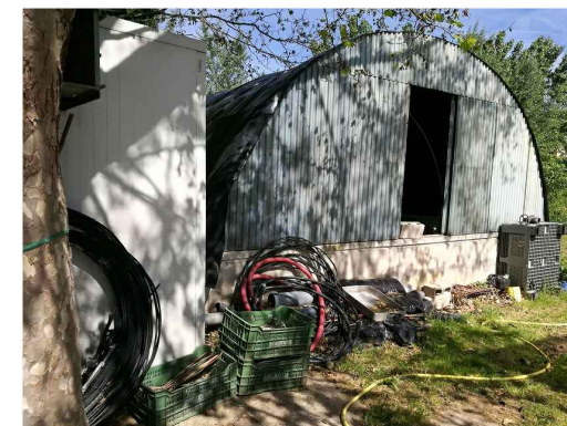
B.- CÁMARA, POZO Y EQUIPOS DE BOMBEO
