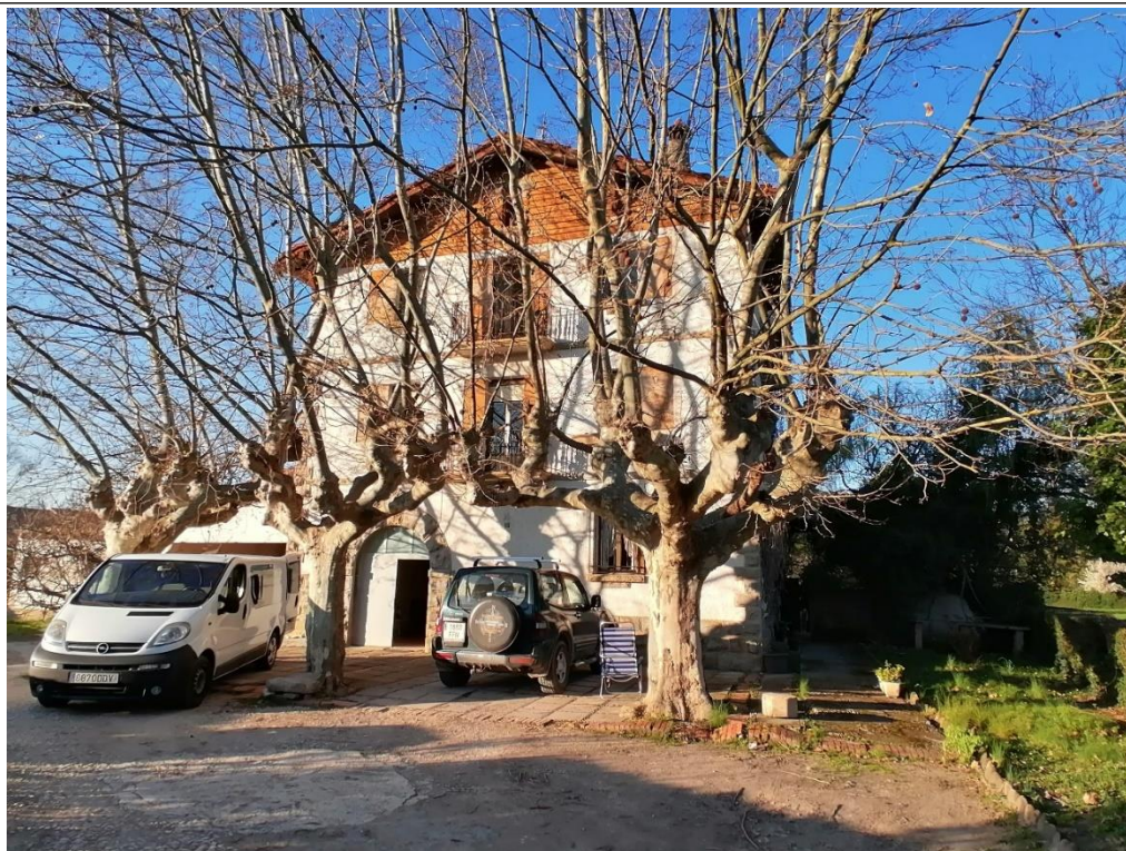
Estado actual, Fachada principal de Casa Soto
