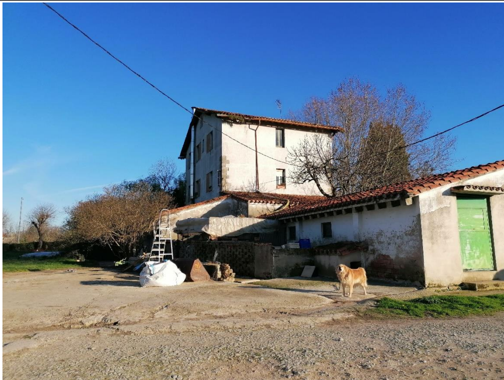
Estado actual, Fachada este y norte y anejos de planta baja.
