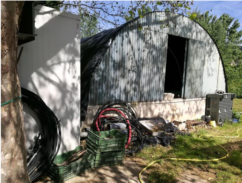
Edificaciones auxiliares de bombeo, cámara frigorífica y almacenaje
