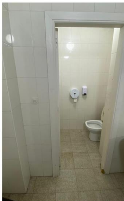
Puertas de aseos y cabinas de 60cms de paso
