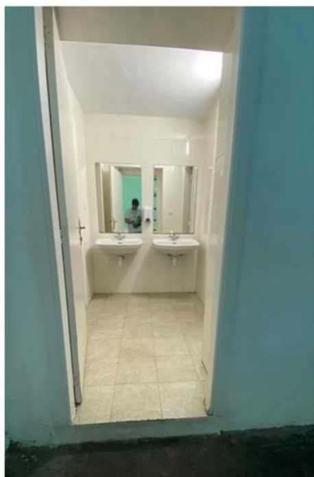
Peldaño en acceso a aseos
