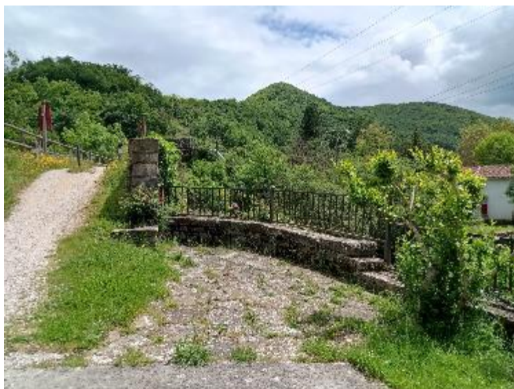
Bajada con pendiente pronunciada en el punto final del tramo. [Fotografía tomada el 20-05-2024]
