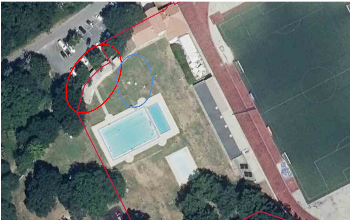
Piscinas en las Instalaciones Deportivas Dantzaleku.
