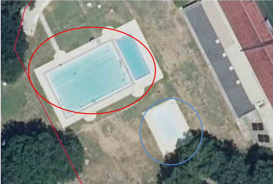
Piscinas en las Instalaciones Deportivas Dantzaleku.
