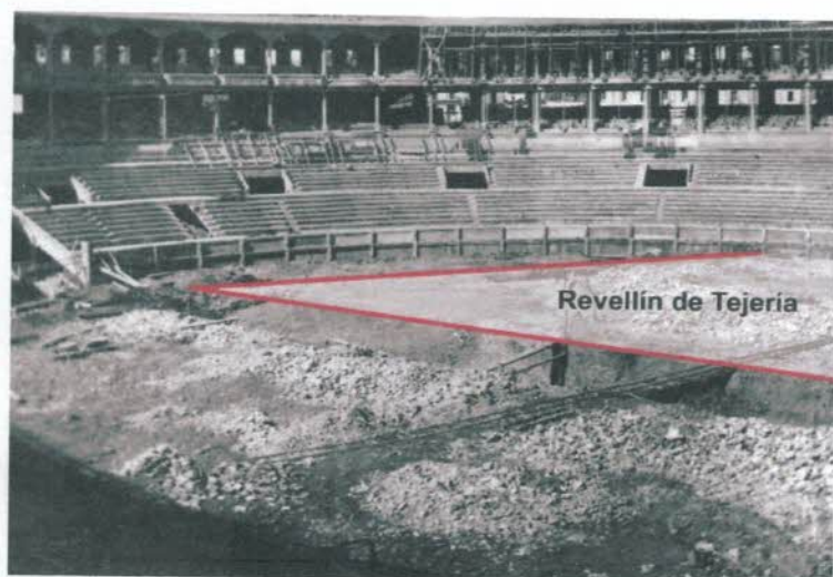
Año 1922. Construcción de la nueva plaza. Zanja para extracción de piedra.
