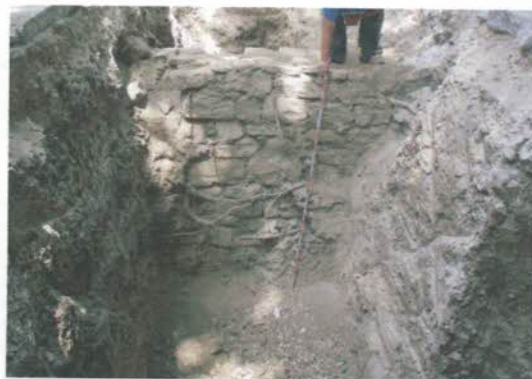
Muro 2. Cara este
