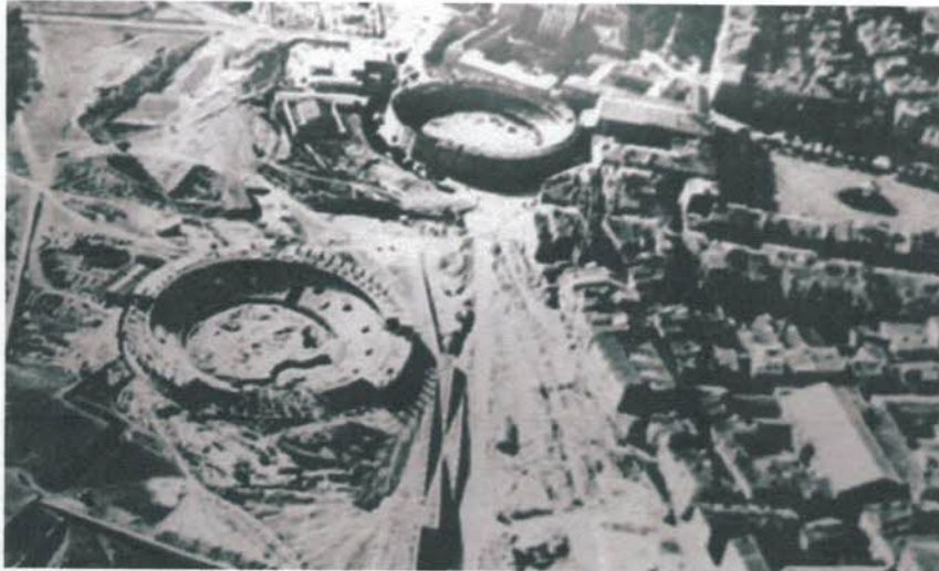
Año 1921. Vista aérea de la plaza de toros vieja (arriba) y la nueva (en construcción)
