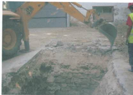
Retirada de sedimento con pala mecánica
