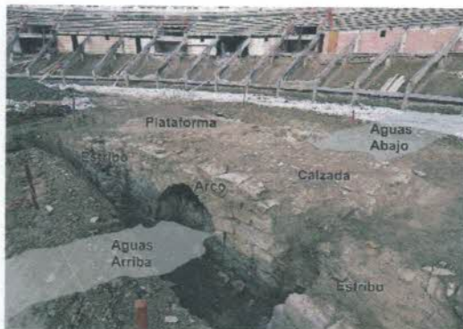
Elementos que componen el puente
