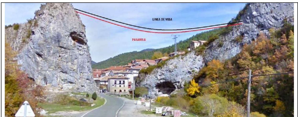
Foto 1: Pasarela nº 2 desde la Pitxorronga, prevista en versión V2 pero no en la versión V3
