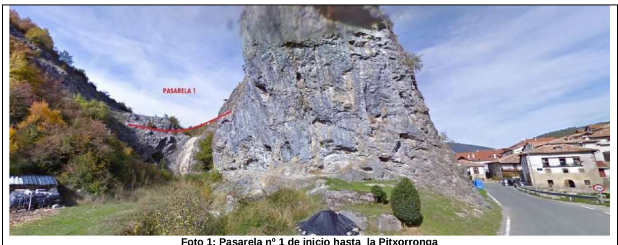
Foto 1: Pasarela nº 1 de inicio hasta la Pitxorronga
