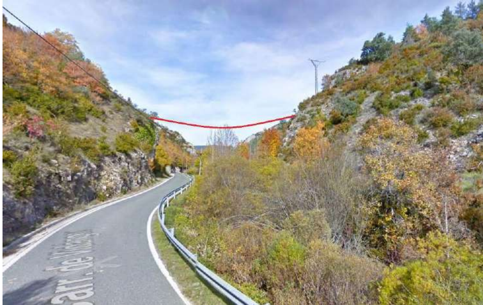
Foto 1: Pasarela nº 3 en Peña Ancha
