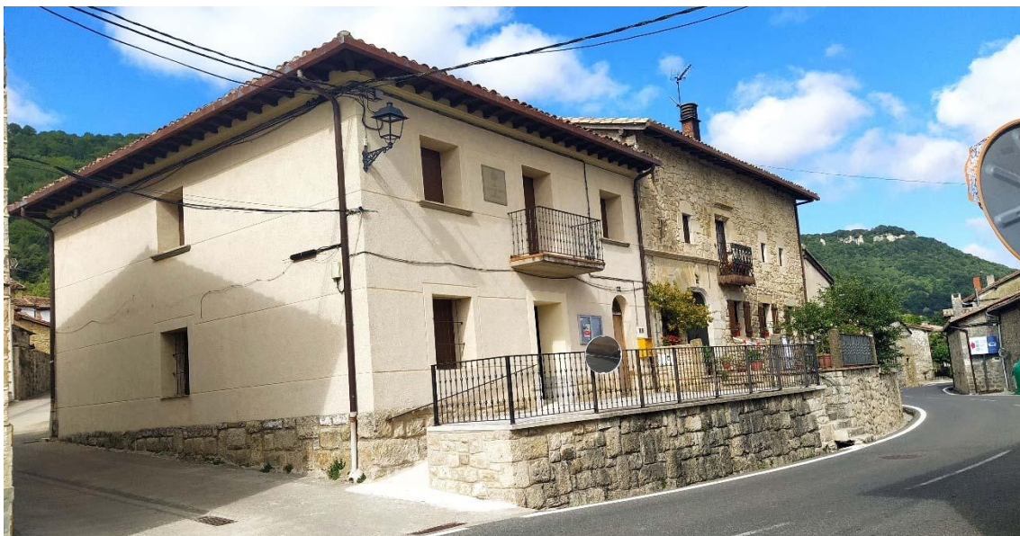
Exterior del edificio- Se mantiene igual
