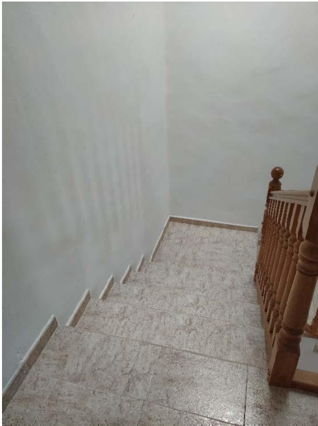
Escaleras de acceso a planta 1.
