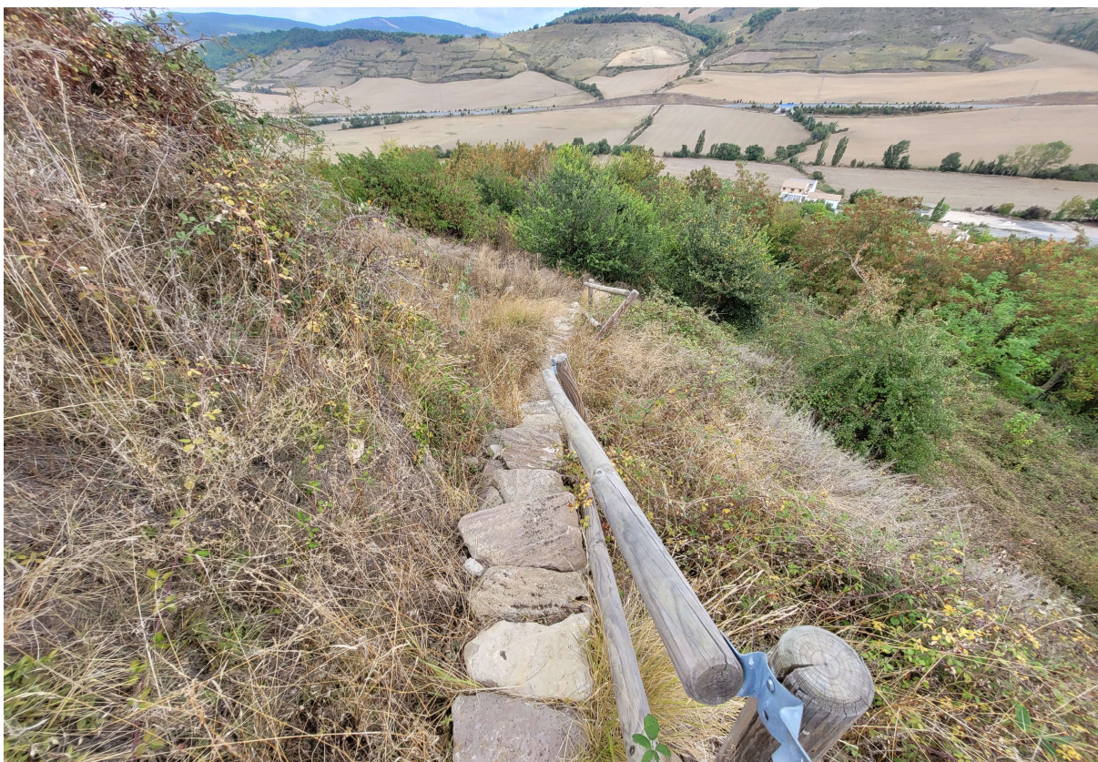
Imagen estado actual camino de acceso
