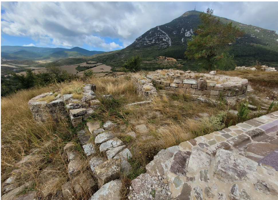
Imagen estado actual puerta de entrada
