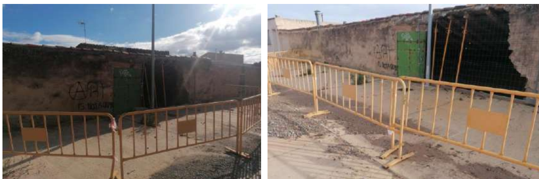
Vista actual de fachada a Calle Castillo (zona a derribar)
