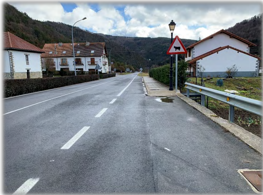
Fotografía 1: Discontinuidad de acera, salida a arcén.
