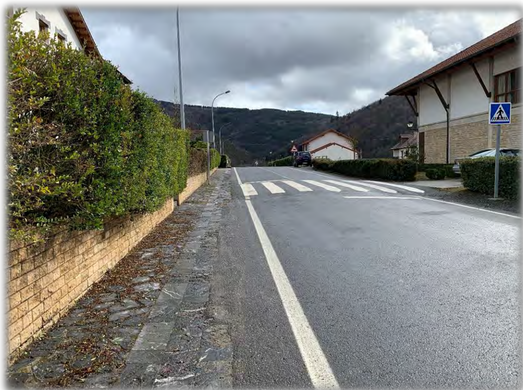
Fotografía 2: Al fondo acera si continuidad, acceso a la casa del Valle sin acera. La acera de la izquierda de la fotografía carece continuidad en ambos extremos, además de tener un pavimento en mal estado.
