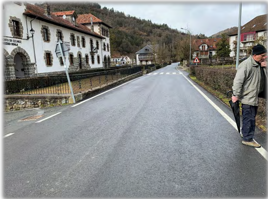
Fotografía 5: El Ayuntamiento no es accesible. Tramo de la travesía, NA-178, sin aceras y con arcenes de unos 20 cm a cada lado.
