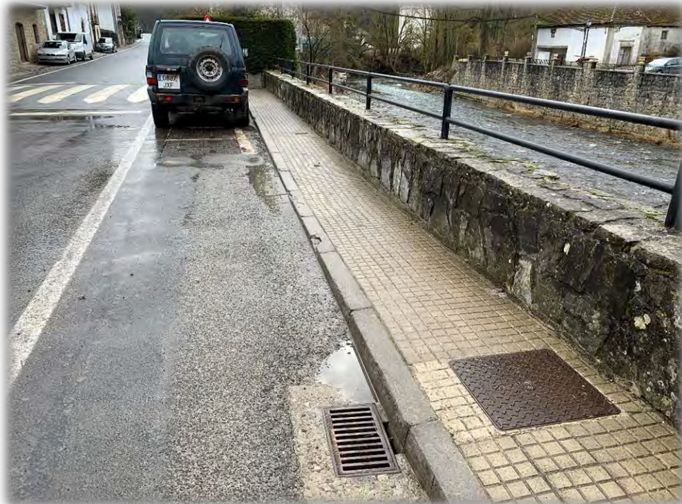
Fotografía 8: Acera no accesible, de menos de 1 m, a la entrada de la NA-140 al centro del pueblo, con paso de peatones. Y espacio de arcén suficiente para ampliar la acera.
