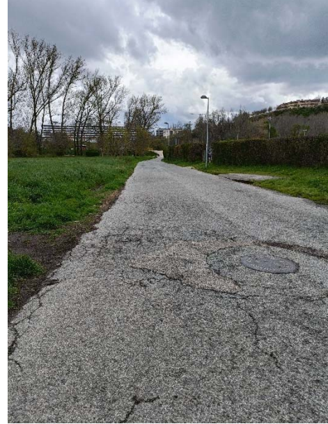
10- Pavimento bituminoso del camino al río
