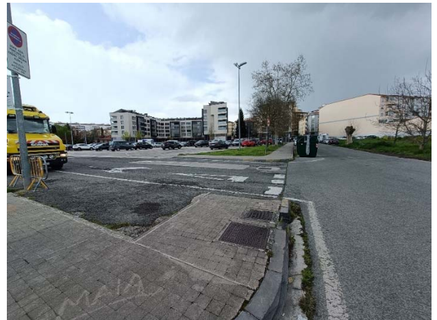
4-Acceso nº3 al aparcamiento por la calle Soto
