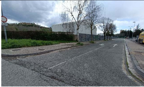
7- Pavimento bituminoso vial exterior sur zona 2
