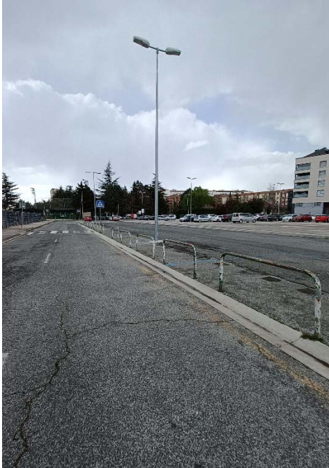
11- Caz de hormigón entre vial y zona estacionamiento zona 2
