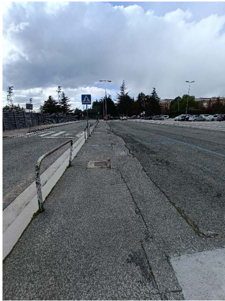
9- Pavimento bituminoso vial exterior sur zona 2
