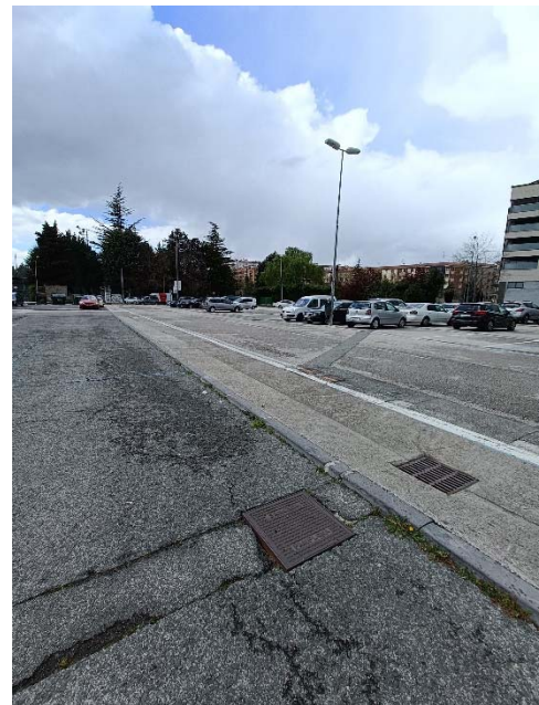
12- Cuneta de hormigón entre zona 1 y zona 2
