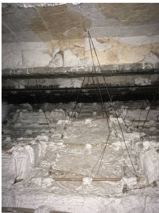
Falso techo salón de actos
