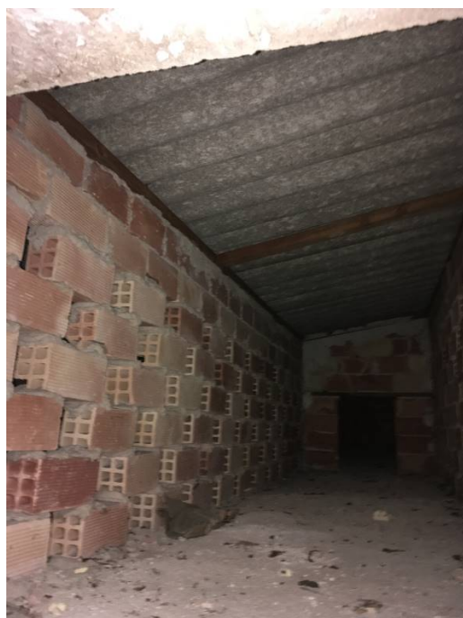
Vista interior cubierta salón de actos
