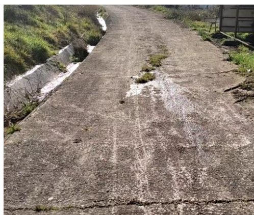
Relieve de zonas de deflación y de acumulación. Agua bajo el pavimento por nivel freático alto
