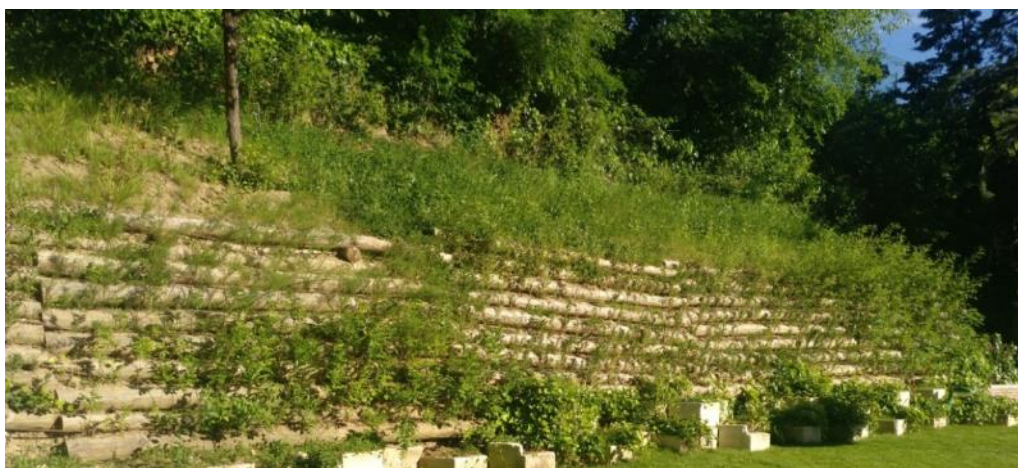
Ejemplo de un talud de elevada pendiente estabilizado con técnicas de bioingeniería. (Ecoingenia 2017)
