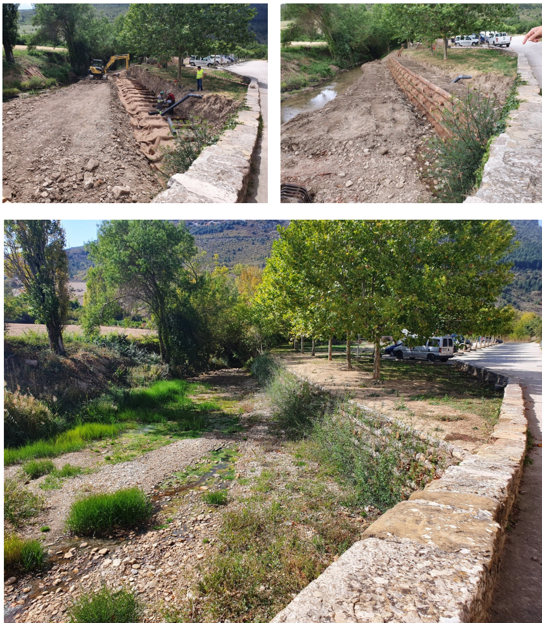
Sucesión de fases de ejecución y desarrollo de una intervención de estabilización de ribera con bioingeniería en Monreal (Navarra). Ecoingenia (2022)
