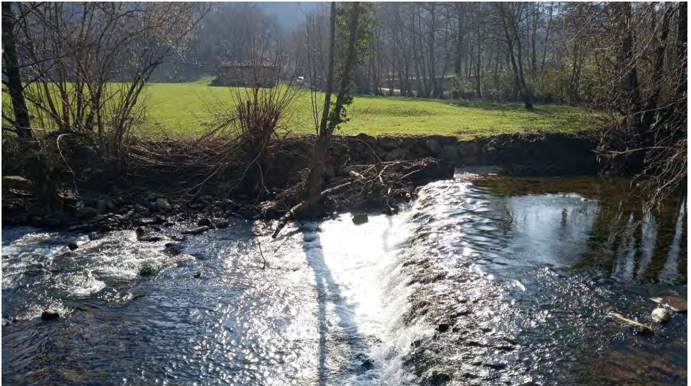
Aspecto del obstáculo a permeabilizar y del prado ubicado en la margen derecha del río Ezkurra, por el que se propone el acceso
