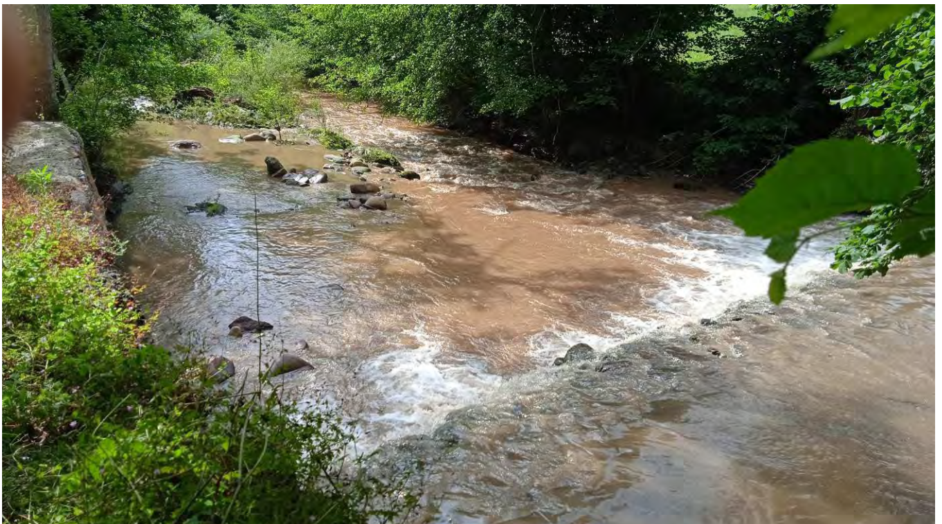
Vista hacia aguas abajo, apreciándose los dos tramos en los que se divide el curso de agua y las distintas cotas de ambos
