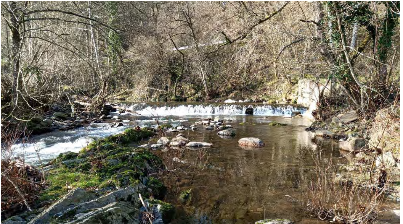
Aspecto del obstáculo a permeabilizar, visto desde aguas abajo, y en el que se aprecia la división del curso de agua en dos tramos, con distinto desnivel.
