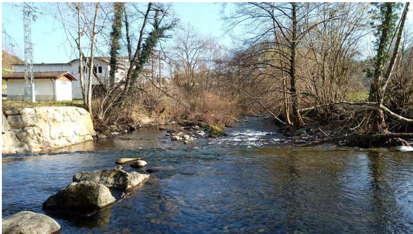
Imagen general, hacía aguas abajo, y en la que se observa en la margen izquierda las instalaciones de la Mancomunidad de Malerreka
