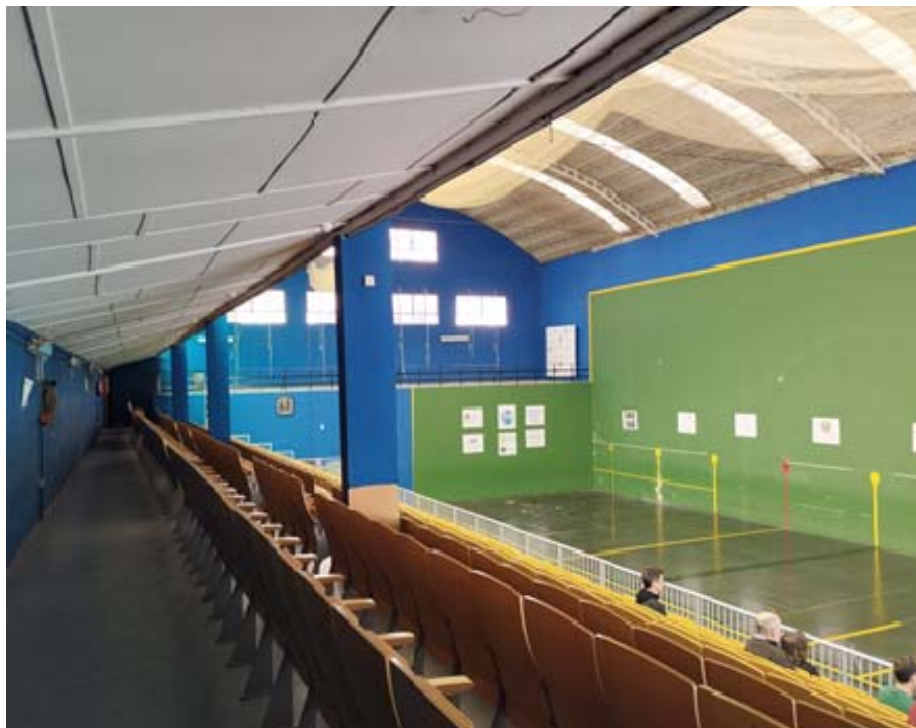
Foto 02: Interior del edificio desde el pasillo superior.
