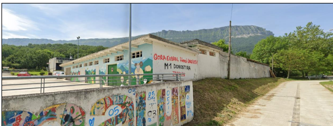
Imagen del edificio existente en la zona de implantación del albergue.
