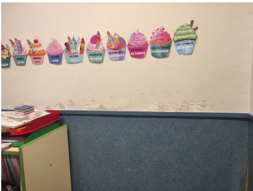
Zócalos de aulas de planta semisótano
