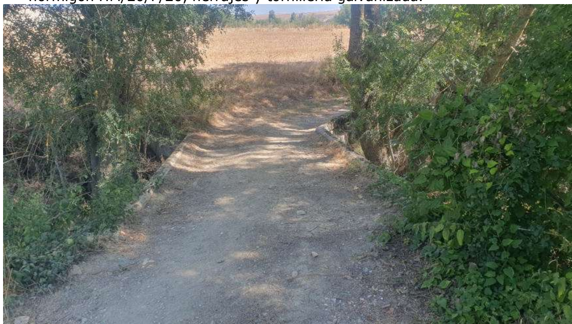
Imagen del puente en Galdairu4 donde se van a colocar barandillas
