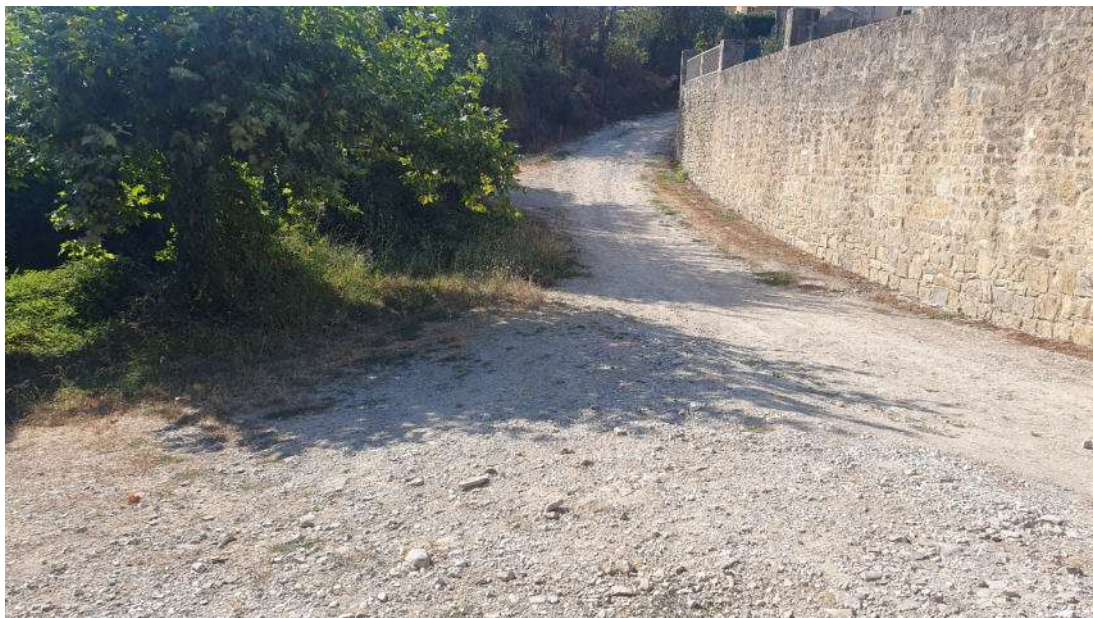
Imagen de Galdairu 2 a pavimentar
