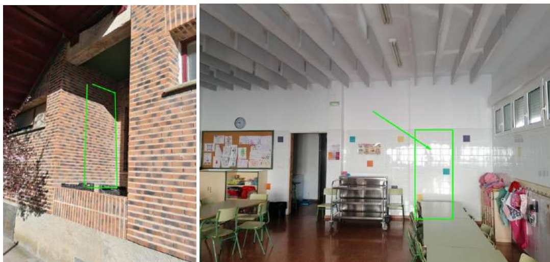
Localizador de la puerta de evacuación del comedor – Exterior - Interior
