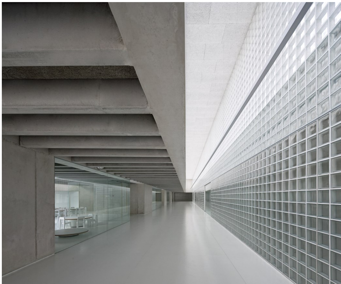
Foto 2: Vista espacio central (fin de obra)
