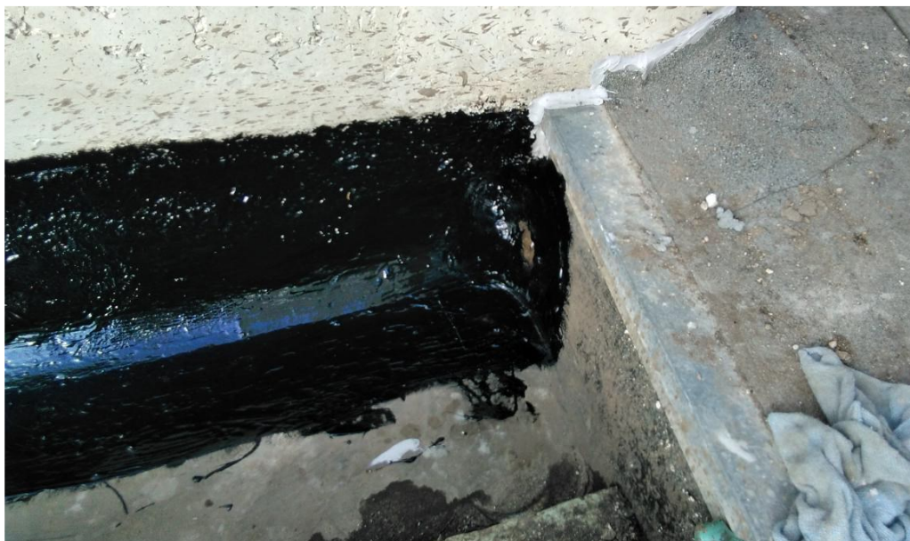
Foto 6: Imagen de una de las reparaciones realizadas con soluciones líquidas
