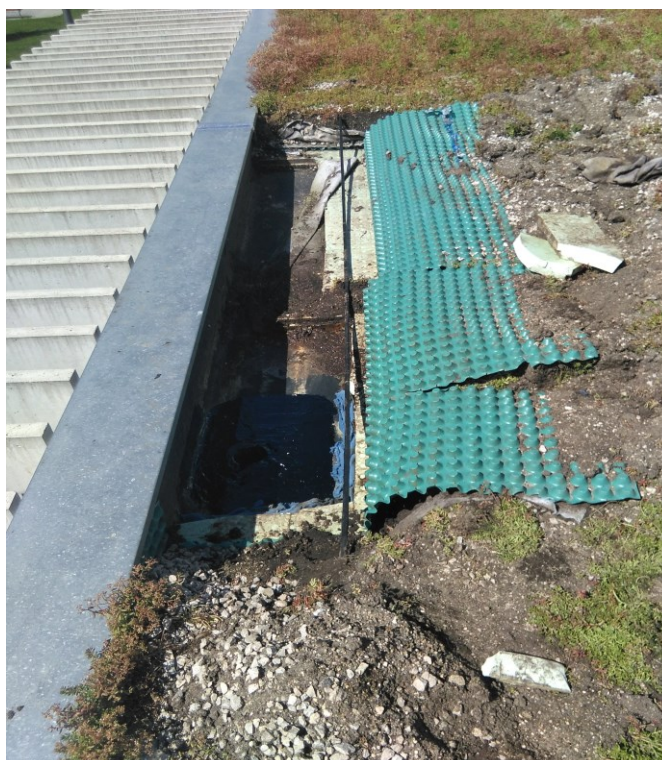
Foto 4: Cubierta arreglos año 2022
