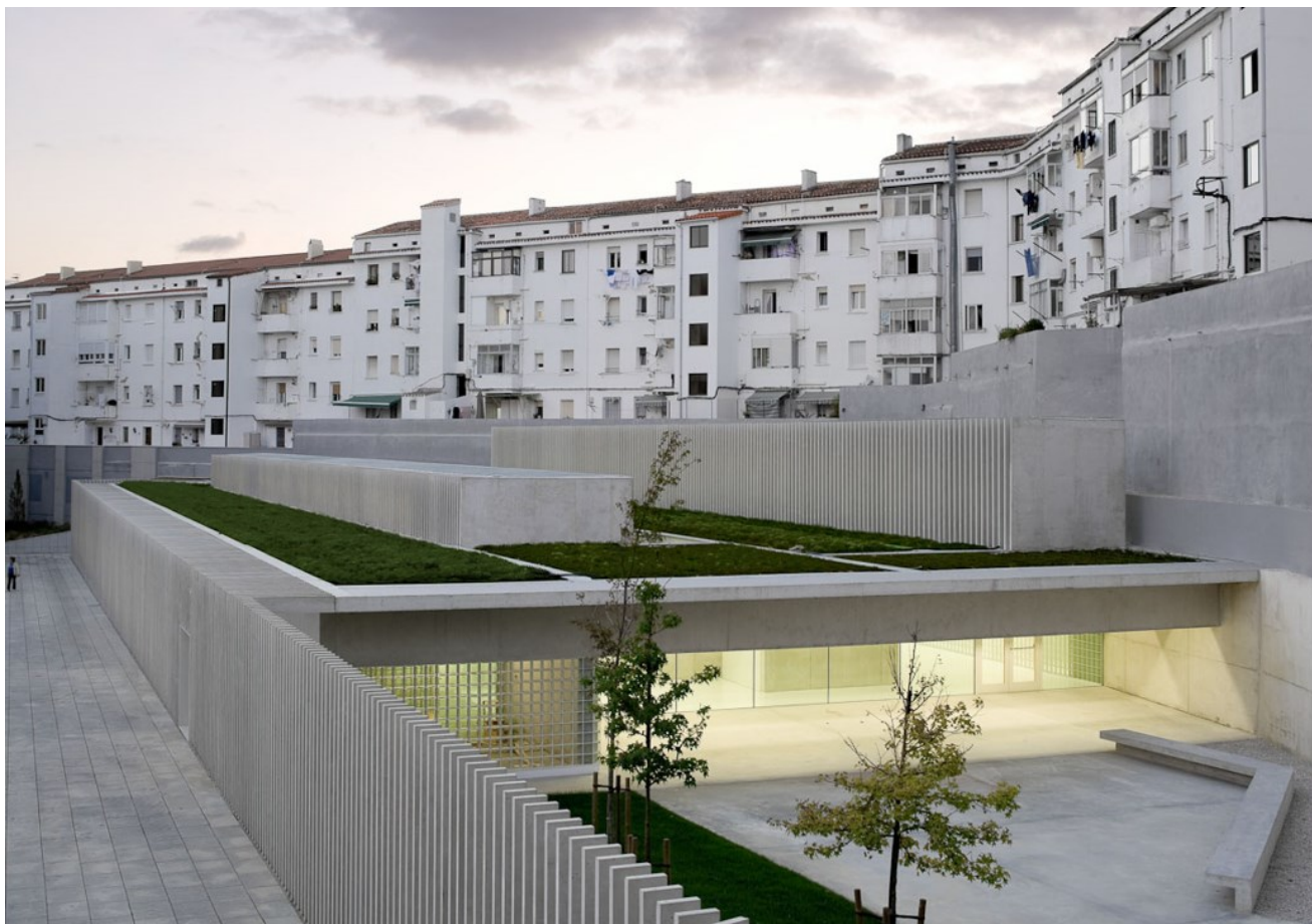
Foto 5: Vista cubierta (fin de obra)
