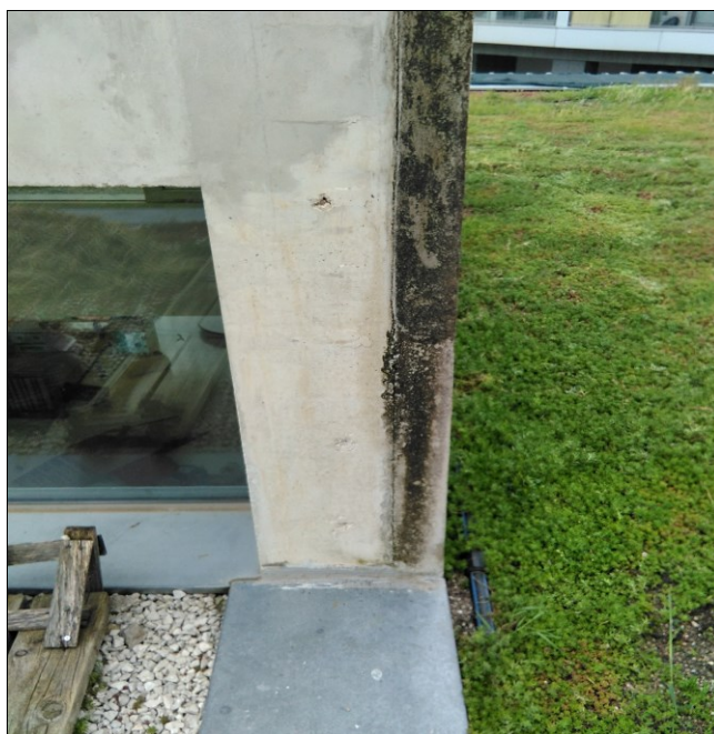
Foto 11: Muro lucernario módulos
