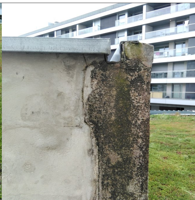
Foto 12: Muro lucernario módulos
