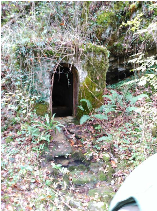
Zona de la captación
