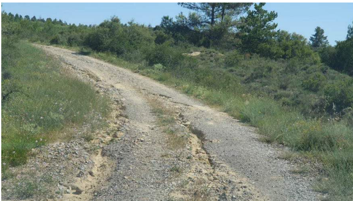
Camino donde la riada ha erosionado la capa de rodadura. Junio de 2023
