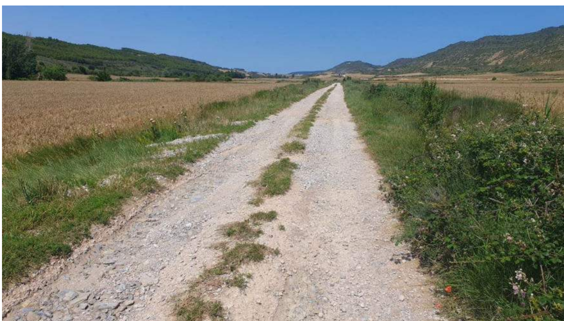
Otra fotografía del camino donde la riada ha erosionado ligeramente la capa de rodadura
