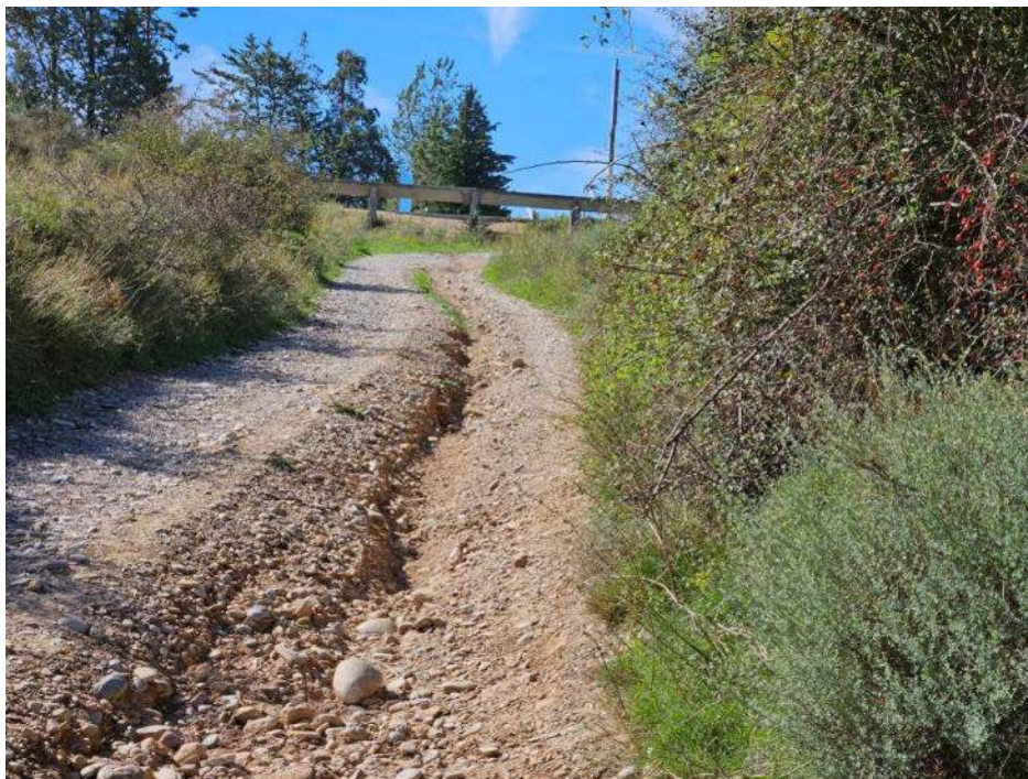
Camino donde la riada ha erosionado la capa de rodadura. Septiembre de 2023
