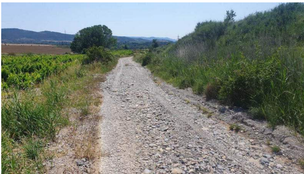
Camino Paco de Uñesa. Daños graves en la capa de rodadura. Junio de 2023
