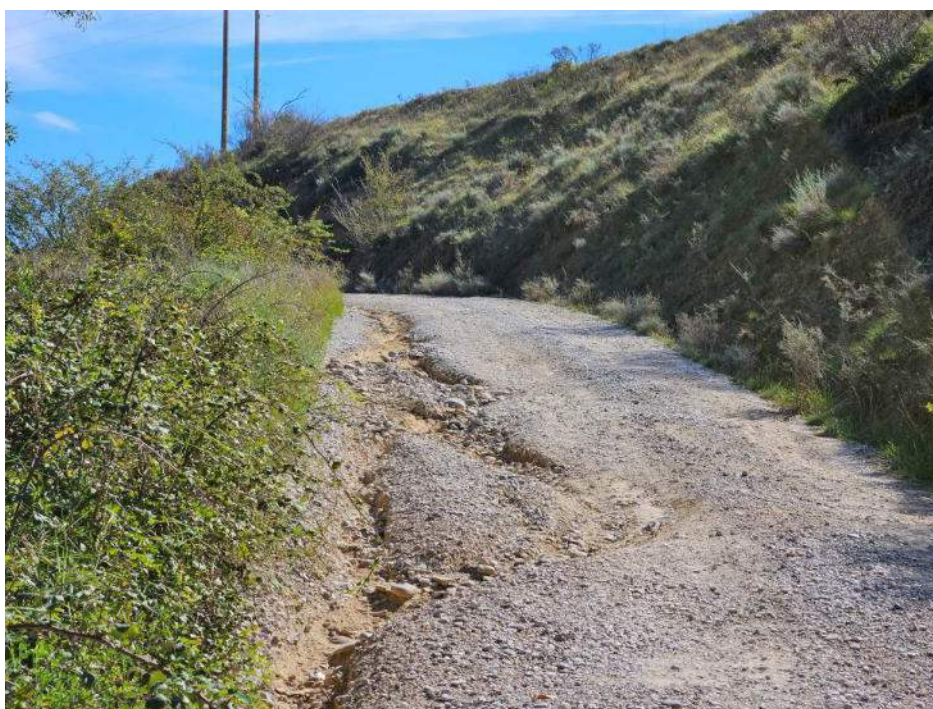
Otra fotografía del camino donde la riada ha erosionado la capa de rodadura. Septiembre de 2023
