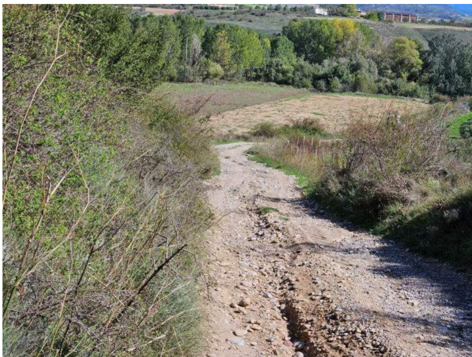
Otra fotografía del camino donde la riada ha erosionado la capa de rodadura. Septiembre de 2023
