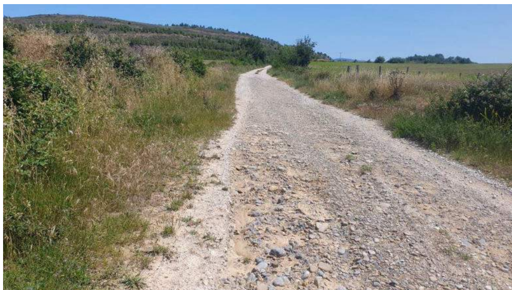
Camino Paco de Uñesa. Daños graves en la capa de rodadura. Junio de 2023
