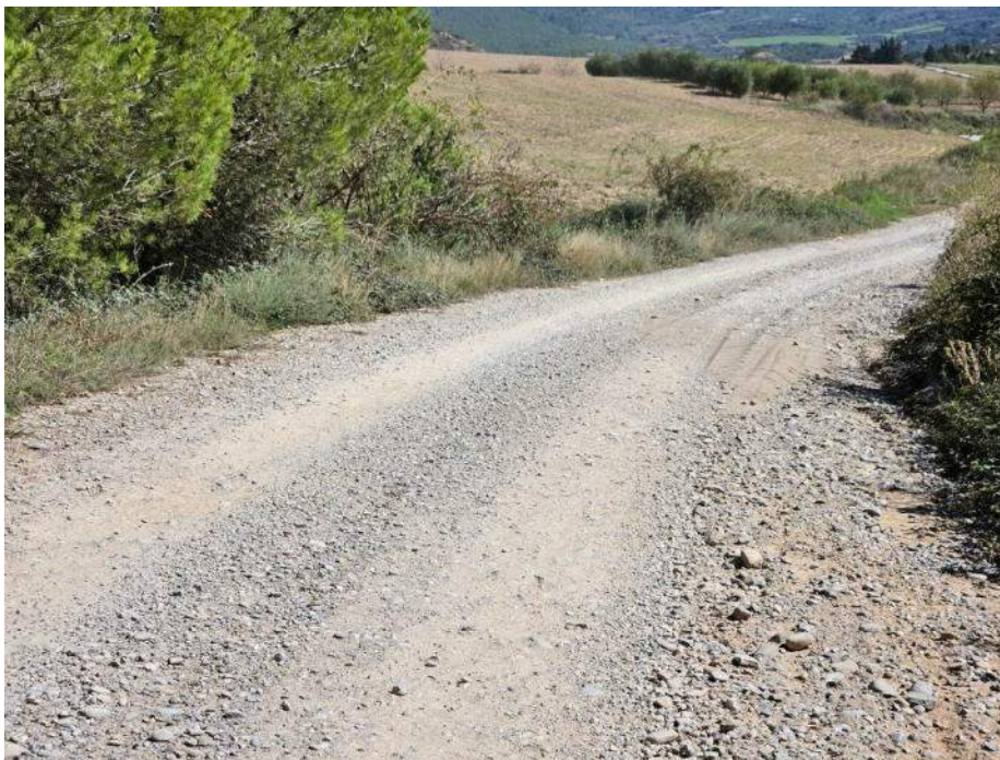
Camino donde la riada ha erosionado la capa de rodadura. Septiembre de 2023
