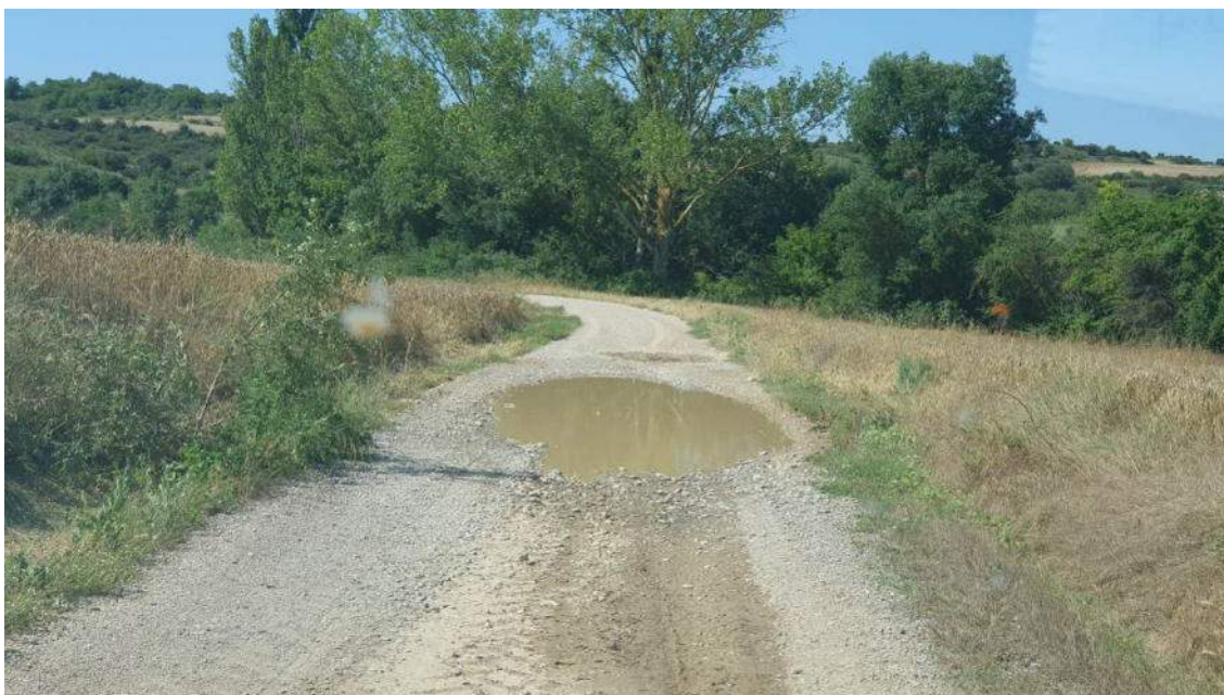
Otra fotografía del camino donde la riada ha erosionado la capa de rodadura y se ha embarrado
