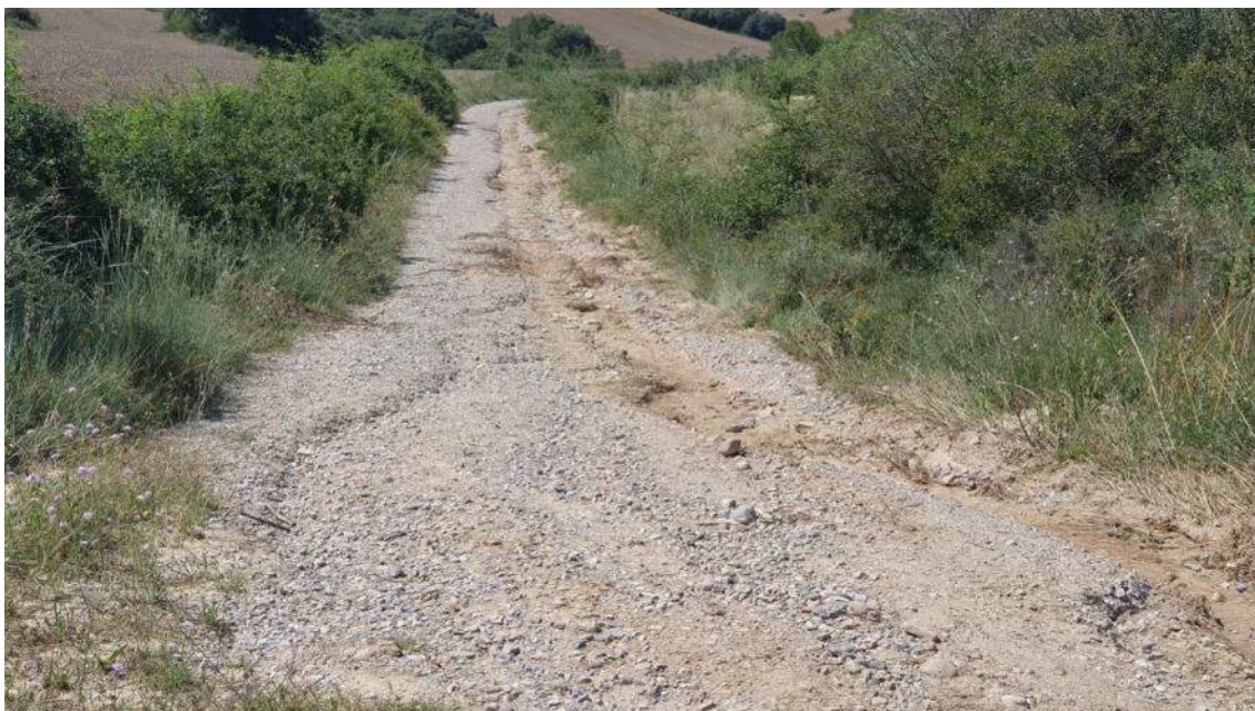
Otra fotografía del camino donde la riada ha erosionado la capa de rodadura. Junio de 2023
