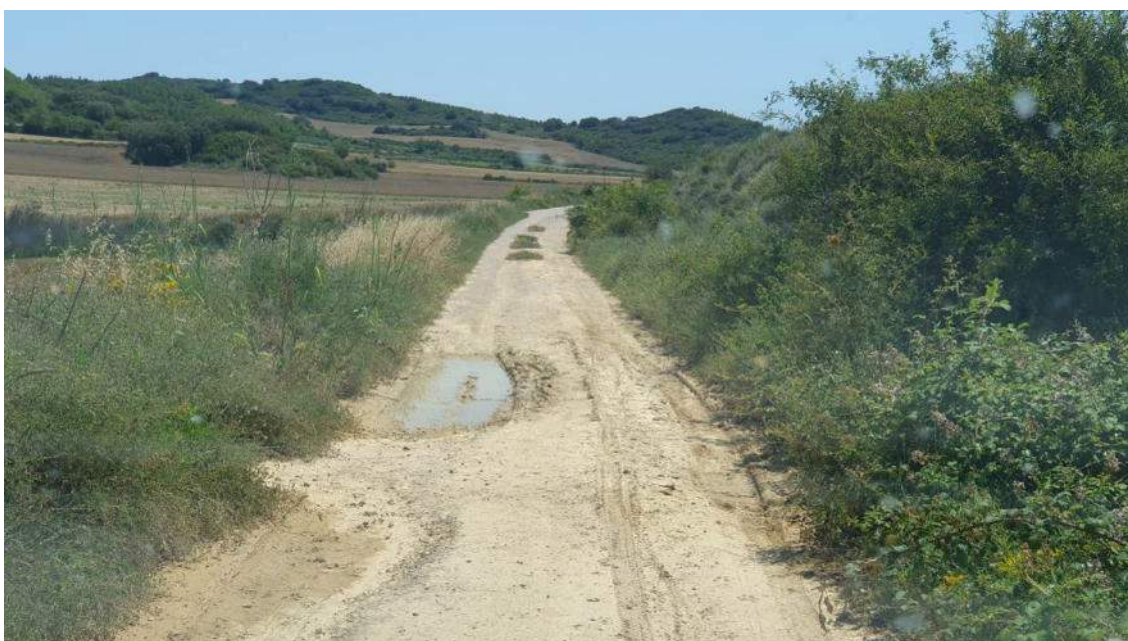
Otra fotografía del camino donde la riada ha erosionado la capa de rodadura y se ha embarrado. Junio de 2023
