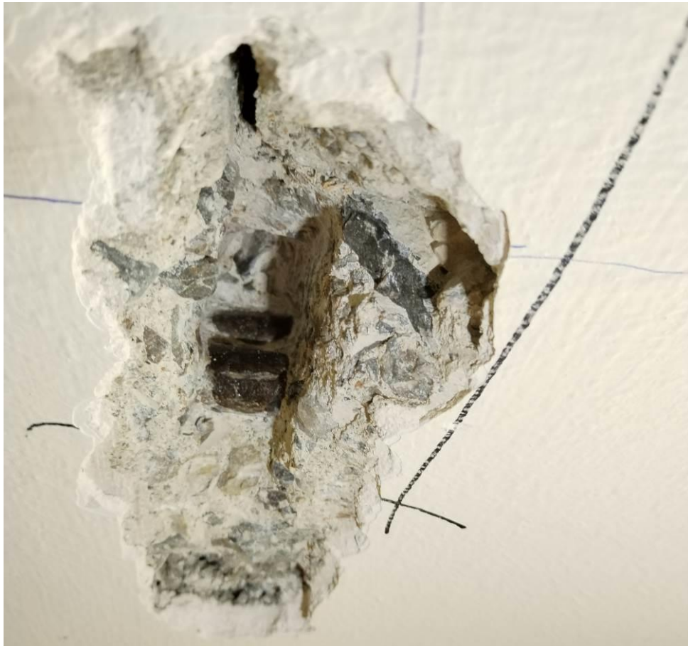
Detalle la doble armadura en el centro del vano del forjado del ala Este
