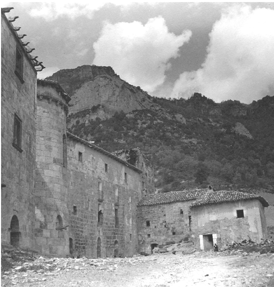
Estado en el que se encontraba el monasterio antes de la restauración. Fuente: archivo IPV
