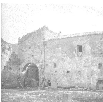
Fachada oeste del ala oriental. Izquierda, encuentro con la torre y de ésta con los restos del muro norte de la desaparecida ala septentrional. Derecha, cuerpo adosado al extremo meridional de la fachada oeste que permitía acceder a cubierto desde la cripta al interior de la iglesia a través de su puerta septentrional. Fuente: archivo IPV
