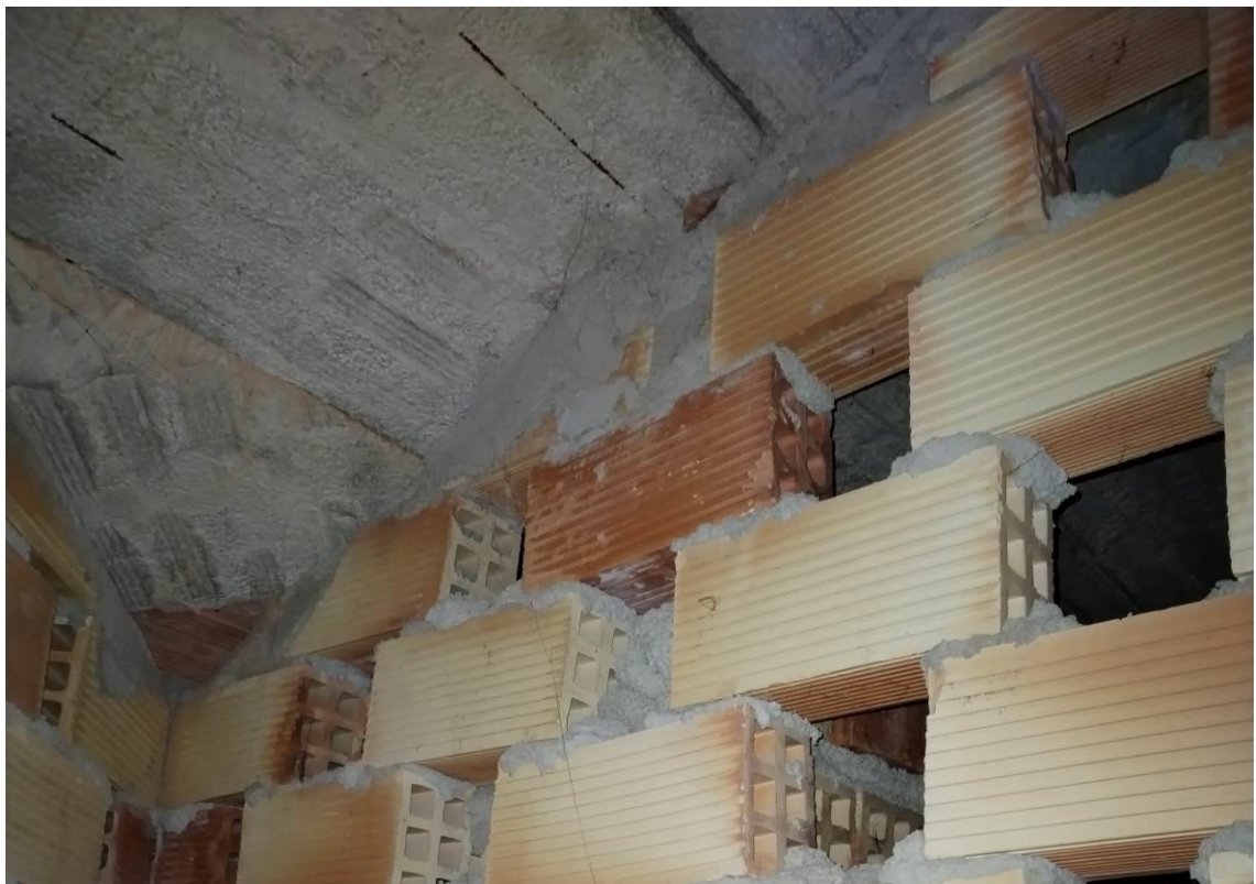
Vista del espacio bajo cubierta
