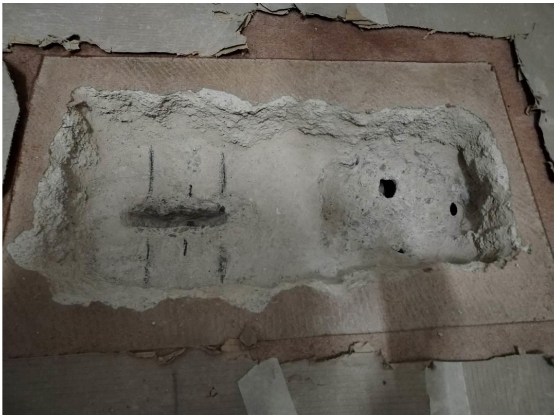
Vistas de la cata por la cara inferior y superior de la cata del forjado del ala Este
