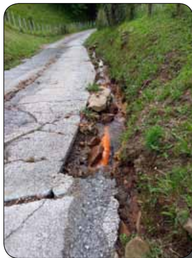
Peñaborda. Desmantelamiento de cuneta hormigonada
