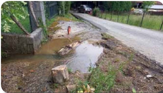
Xantelerreka. Conducción atascada
