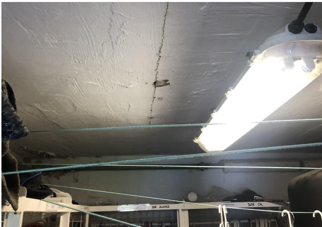
IMAGEN 10 – Oxidación de estructura metálica por falta de protección y goterón.
