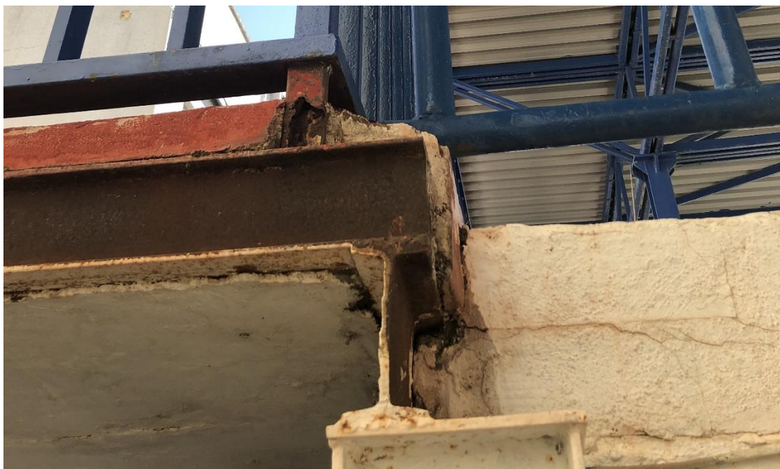
IMAGEN 10 – Oxidación de estructura metálica por falta de protección y goterón.
