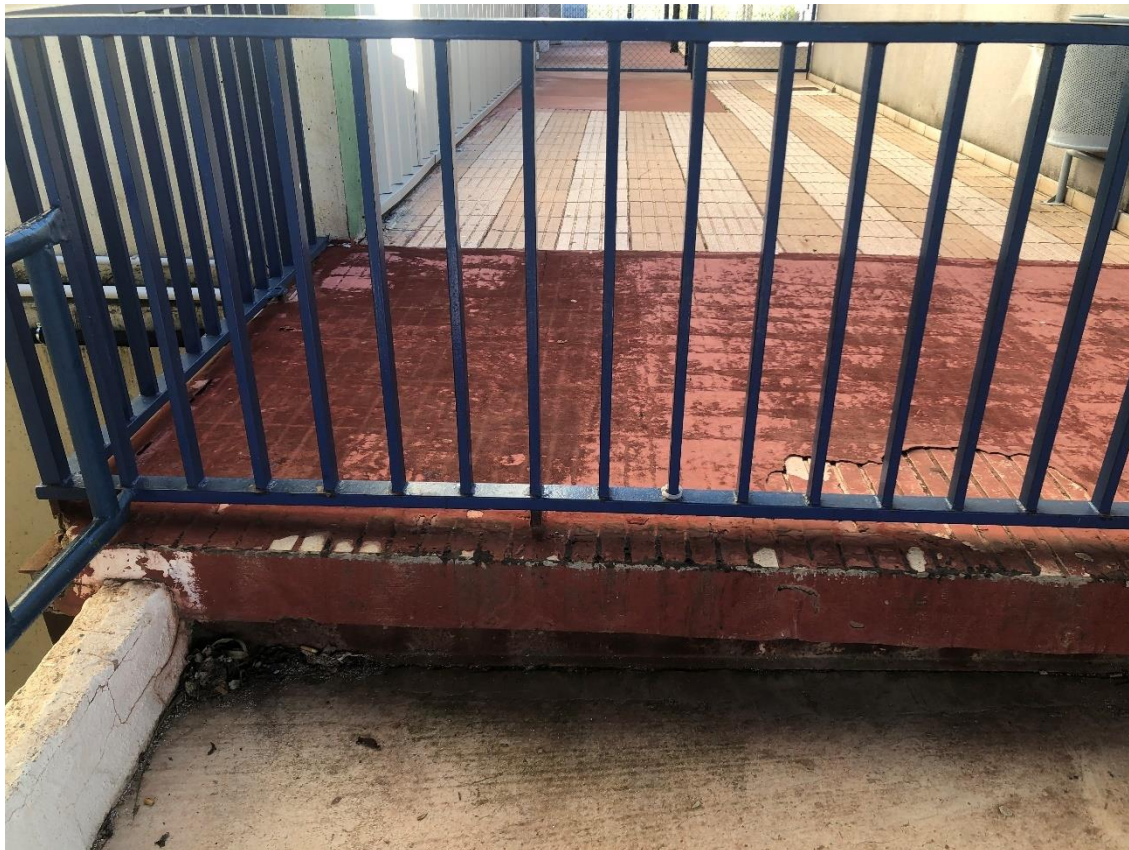
IMAGEN 02 – Falta de impermeabilización de pavimento en contacto en su parte inferior con sala de caldera
